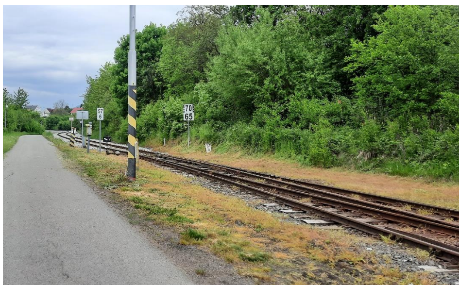
Obrázek 6 - Napojení ŽST Liběšice na revitalizovaný úsek trati
