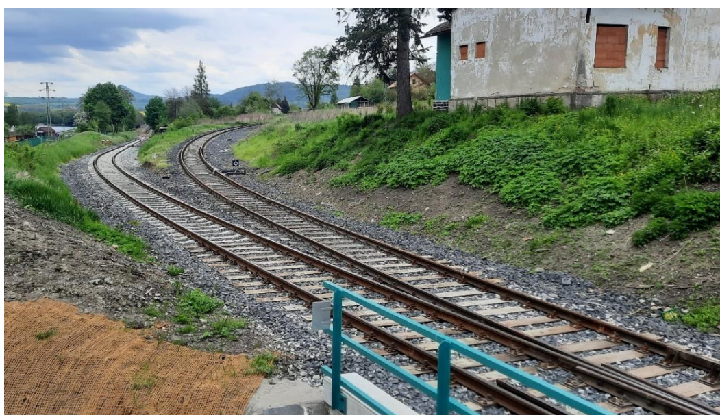
Obrázek 14 - Obnovené spojení do ŽST Ústěč horní nádraží
