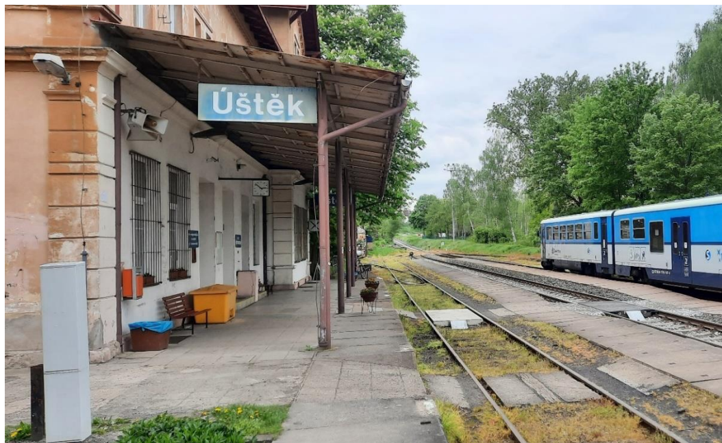
Obrázek 21 - Přístřešek nástupiště u výpravní budovy ŽST Ústěk
