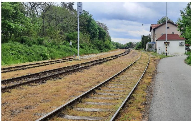
Obrázek 7 - Pohled do stanice ŽST Liběšice od západního zhlaví
