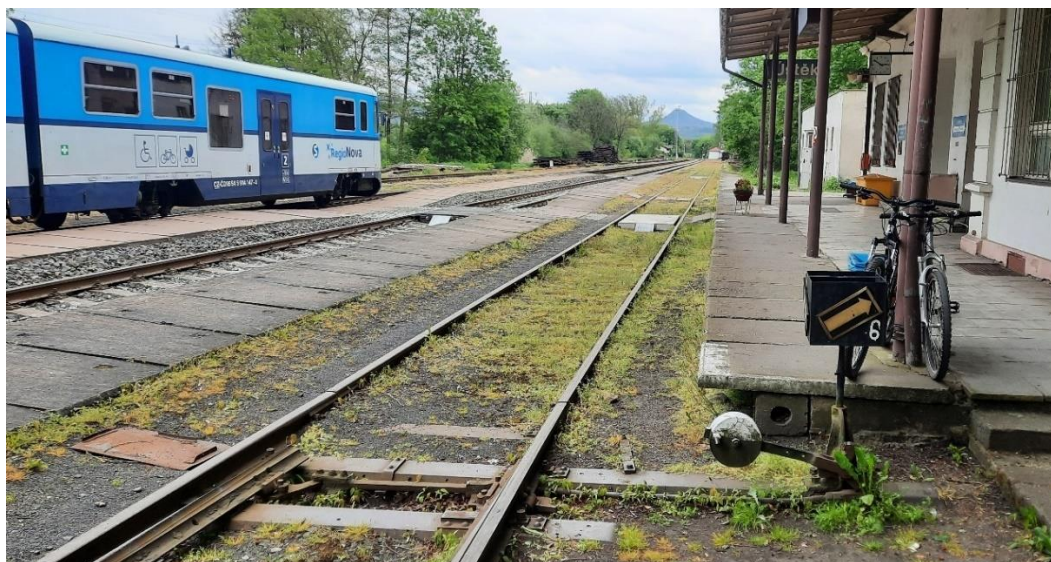
Obrázek 20 - Stávající nástupiště v ŽST Ústěk
