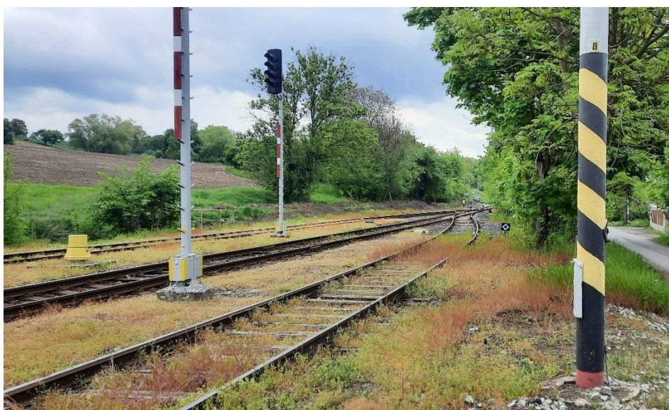
Obrázek 8 - Pohled na východní zhlaví ŽST Liběšice
