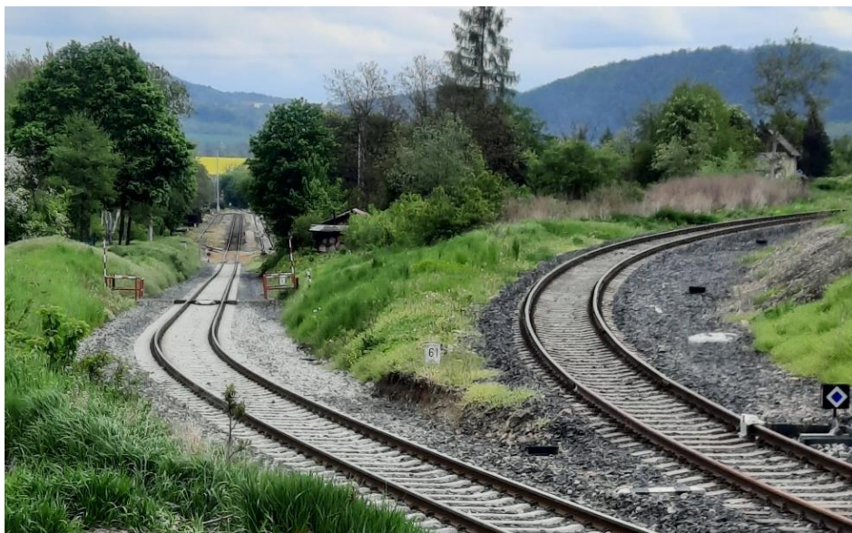
Obrázek 15 - Klesání od obnovené výhybky č. 1 do ŽST Ústěk
