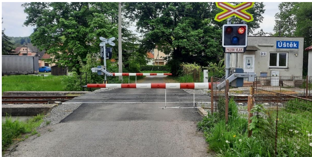
Obrázek 17 - Rekonstruovaný přejezd P3360 u ŽST Ústěk ve směru na ŽST Blíževedly
