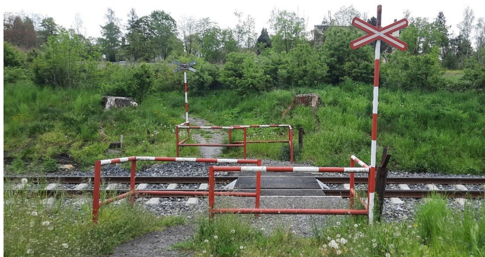
Obrázek 16 - Přejezd P3359 pro pěší s novou přejezdovou konstrukcí
