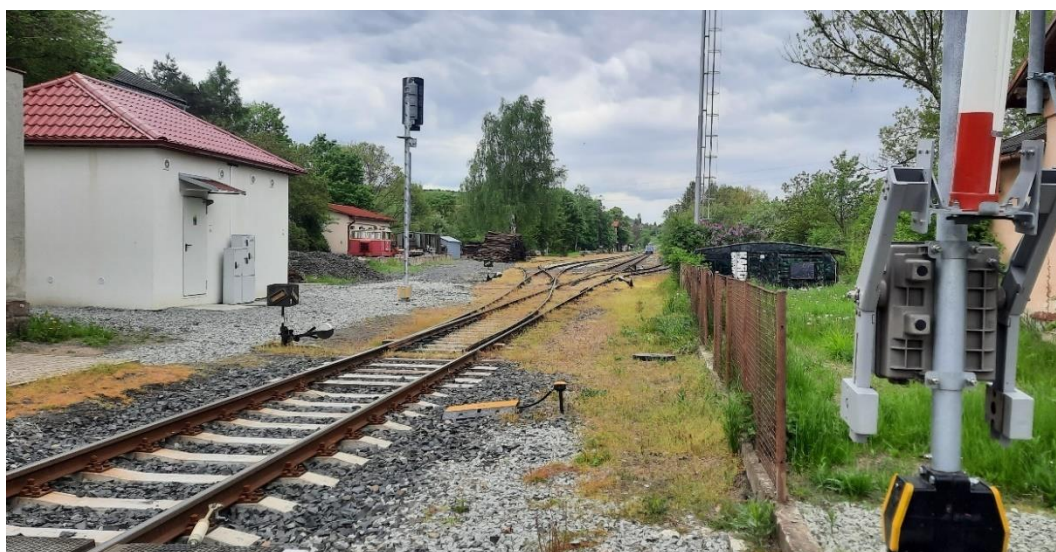
Obrázek 18 - Pohled na východní zhlaví ŽST Ústěk od přejezdu P3360
