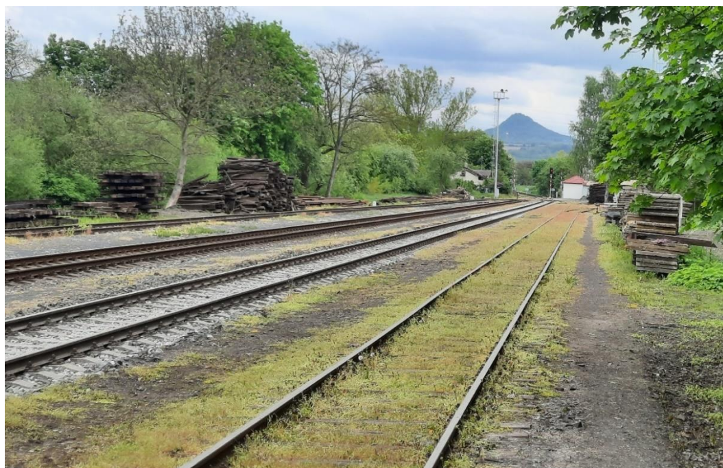
Obrázek 22 - Pohled na východní zhlaví ŽST Ústěk od výpravní budovy
