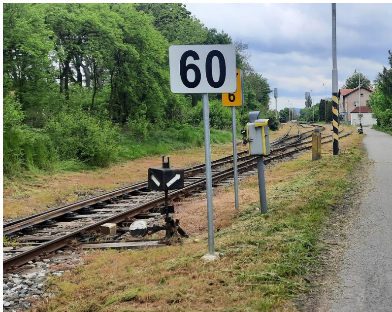
Obrázek 5 - Pohled na západní zhlaví ŽST Liběšice ve směru od ŽST Litoměřice h. n
