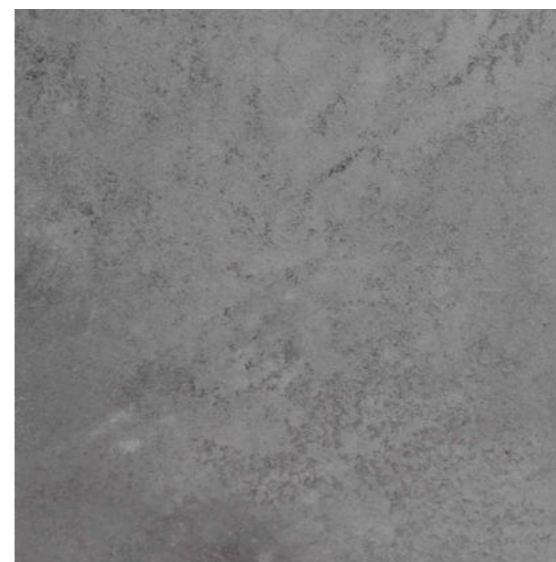
pigmentovaný beton na fasádě v přízemí
