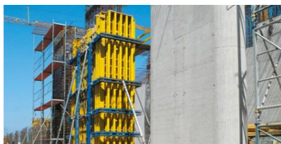
Obr. 19 – Sloupové bednění Tod 50 Zdroj: Sloupové bednění Tod 51. [online]. Copyright © Doka GmbH 2022 [cit. 24.03.2023]. Dostupné z: https://www.doka.com/cz/system-groups/doka-wall-systems/column-formwork/top-50/index
