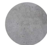
pohledový beton s ochranným nátěrem
