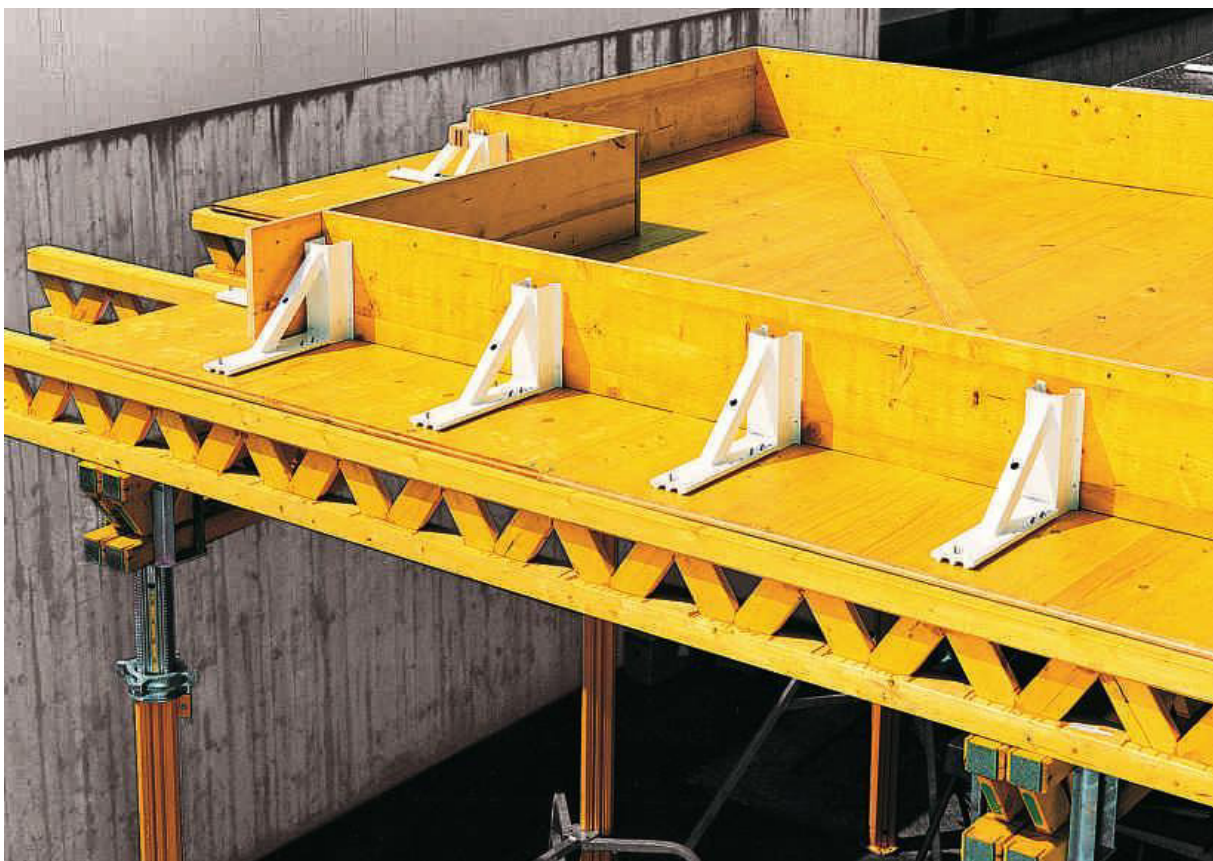
systém úchytnů pro betonáž vodorovných záběrů
