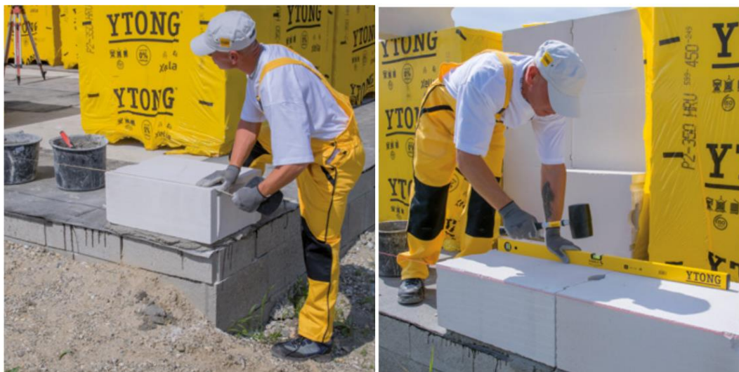
Obrázek 30: Založení první řady pomocí zednické šňůry [34] Obrázek 31: Pokládka první řady tvárnic [34]
