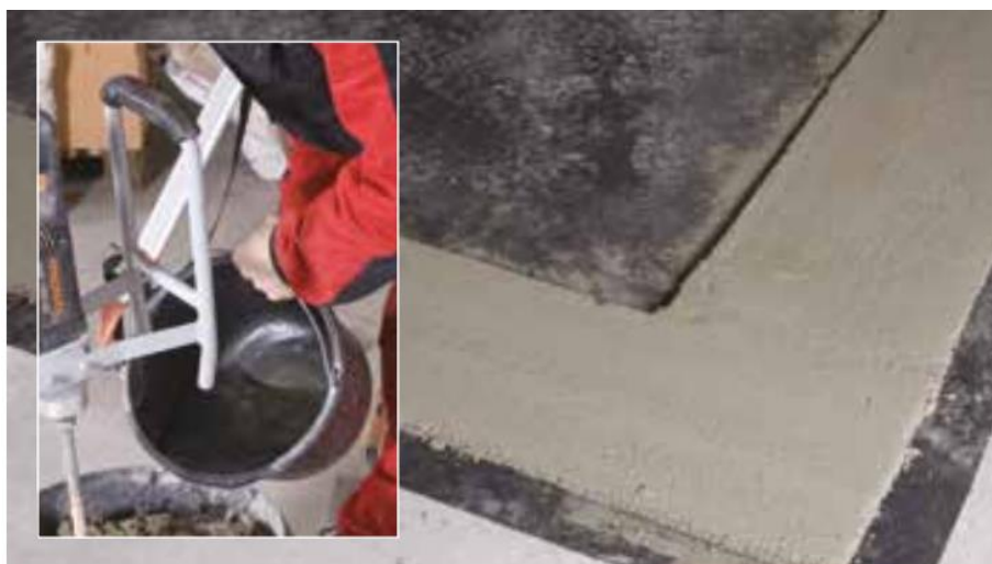
Obrázek 21: Příprava maltového lože na položení první vrstvy cihel [33]
