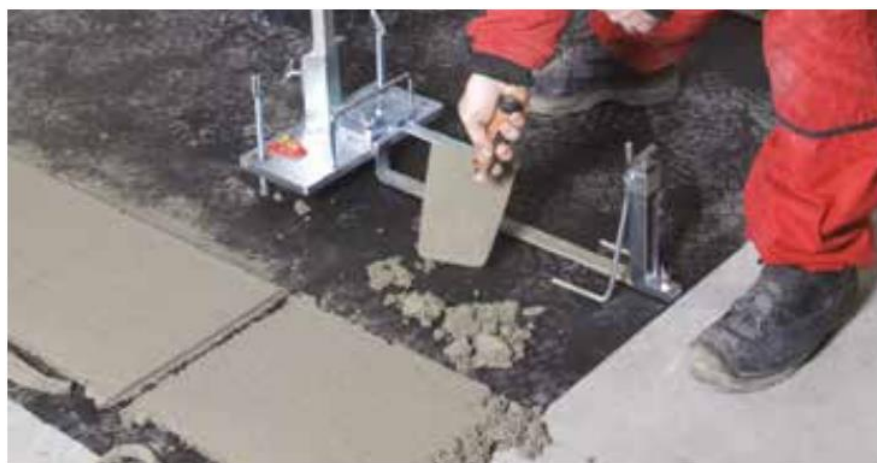
Spotřeba základací malty závisí na průměrné tloušťce maltového lože
