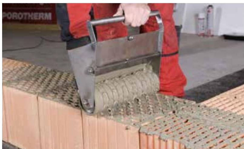
Obrázek 25: Nanášení malty na žebra cihel v ložné ploše [33]
