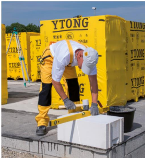
Obrázek 28: Stabilizace uložené tvárnice [33]
