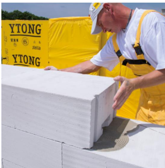
Obrázek 32: Přesah tvárnice o 100 mm [34]
