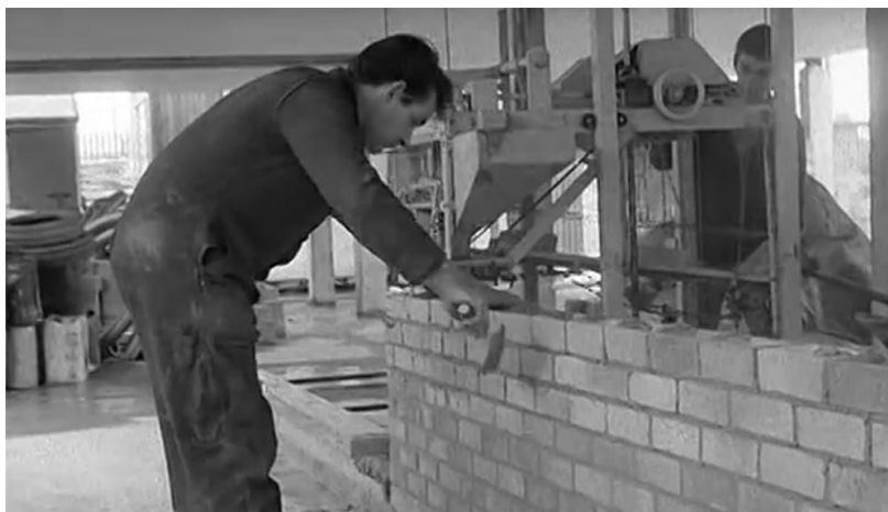
Obrázek 7: "Motor Mason" - v akci s pomocí zedníků - rok 1967 [21]
