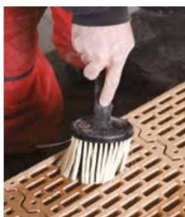
Před nanášením malty doporučujeme navlhčit ložnou plochu cihel
