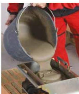
Malta Porotherm Profi se připraví podle návodu na zadní straně obalu
