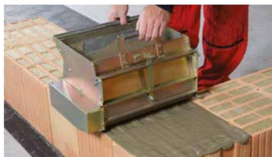
Nanášení malty pomocí maltovacího vozíku
