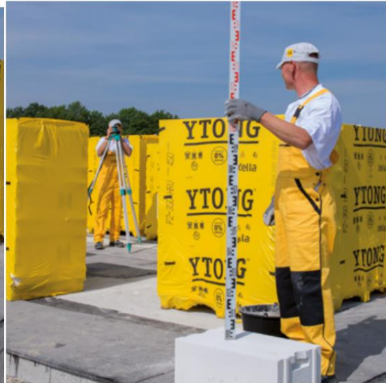
Obrázek 29: Výšková kontrola rohových tvárnic [33]
