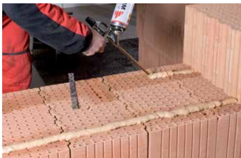
Na vyrovnanou řadu cihel se rovnoběžně nanesou 2 pruhy zdící pěny o průměru cca 3 cm ve vzdálenosti cca 5 cm od okrajů
