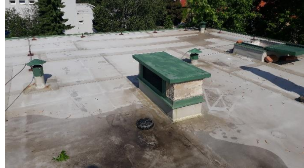
Obrázek 6.: Fotografie střechy v oblasti vtoku
