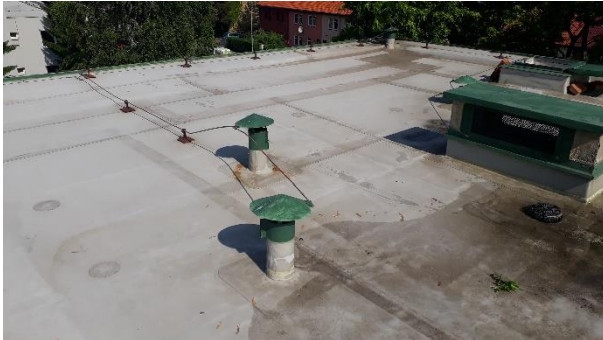
Obrázek 5.: Fotografie střechy pořízená při prohlídce stávajícího stavu v rámci soutěže Solar Decathlon 21/22
