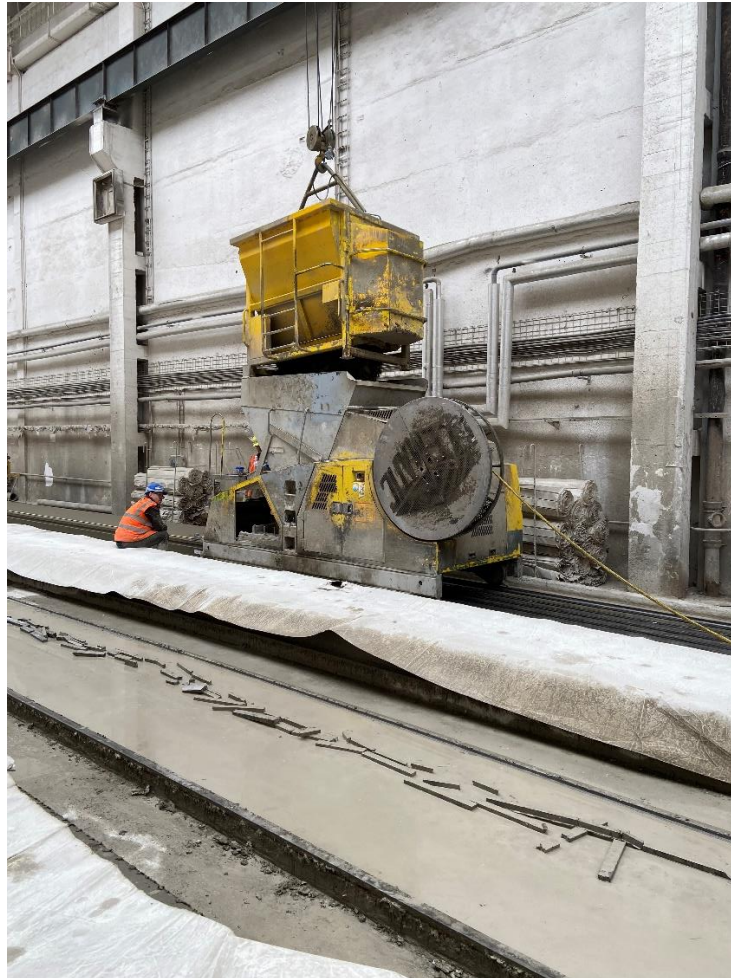
Obrázek 1 – doplnění betonové směsi bádii do extrudéru [1]
