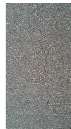
P1 Silniční asfalt
