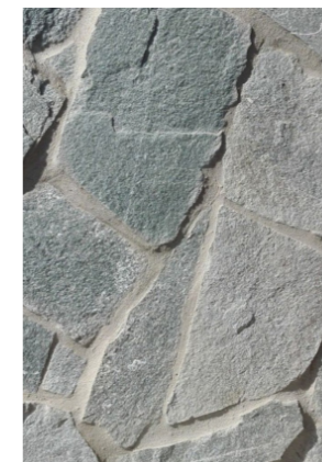
P2 kamenná dlažba - veřejný prostor
