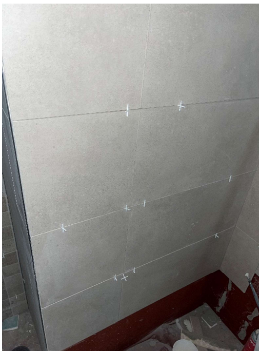
Obrázek 13: Použití vymežovacích křížků (vlastní)
