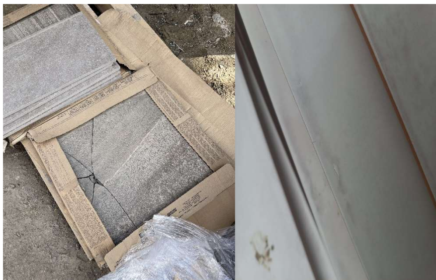
Obrázek 3: Poškození dlažby při přepravě a poškození obkladu z výroby (vlastní)
