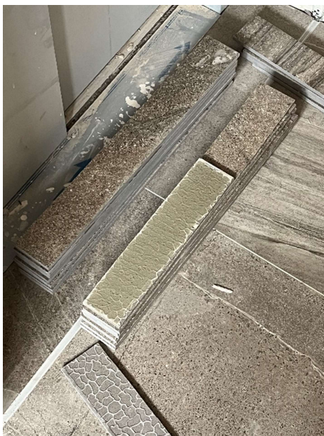
Obrázek 7: Nanášení lepidla "buttering"
