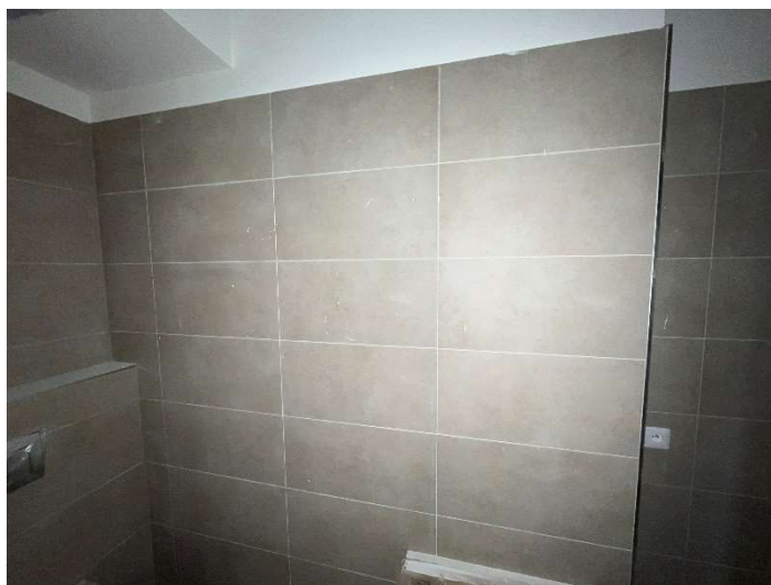
Obrázek 9: Pokládka na stříh (vlastní)
