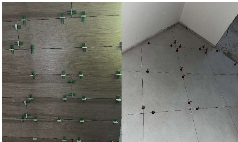
Obrázek 14: Použití klínek a spon pro zajištění rovinnosti obkladů a dlažeb (vlastní)
