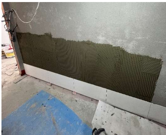
Obrázek 8: Nanášení lepidla "floating" (vlastní)
