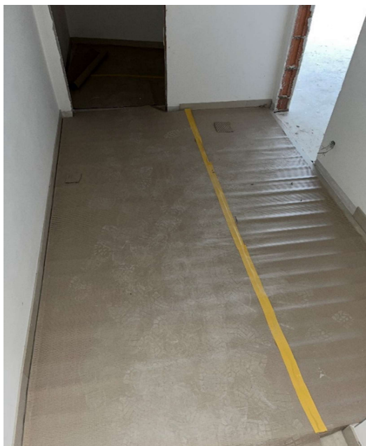
Obrázek 17: Ochrana dlažby proti poškození (vlastní)
