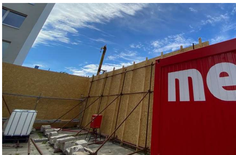
obr. č. 3 – Oplotenie staveniska – protihluková stena, v. = 3,75 m
