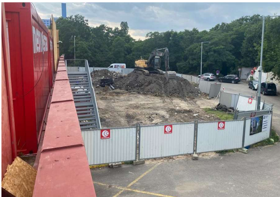
obr. č. 2 – Oplotenie staveniska, v. = 2,0 m
