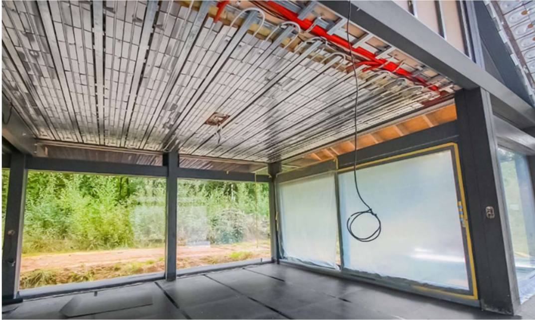
Obr. 18: Schématický obrázek stropního vytápění
