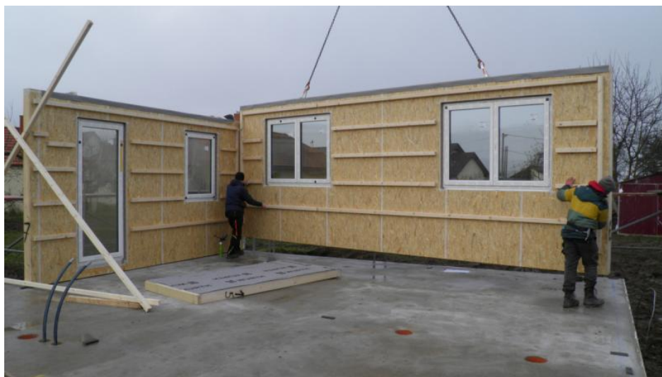
Obrázek 19 Prefabrikovaná dřevostavba (autor: Moravské dřevostavby) (25)
