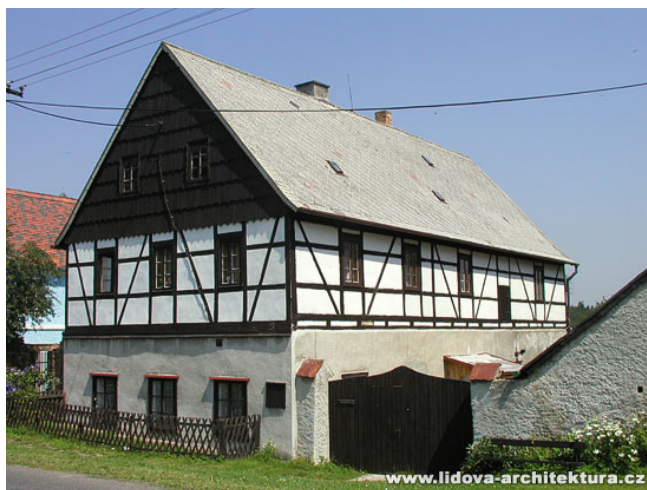
Obrázek 3 Hrázděná konstrukce patra domu, okr. Chomutov (5)
