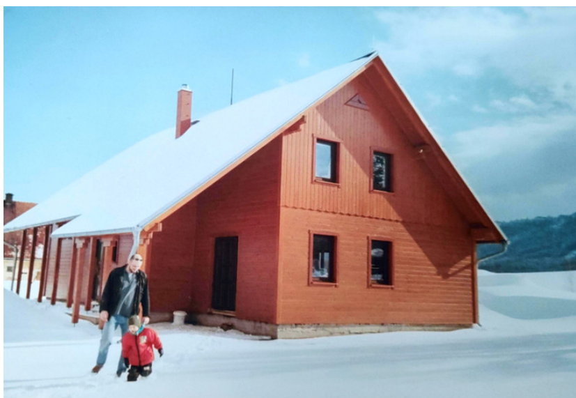
Obrázek 20 Dokončená stavba RD Křínice, 2002 (archiv autora)
