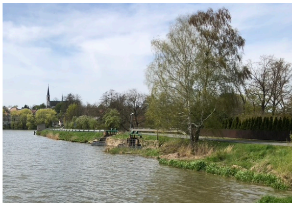
Foto 7 - Pohled na hráz Vavříneckého r. z pravého břehu
