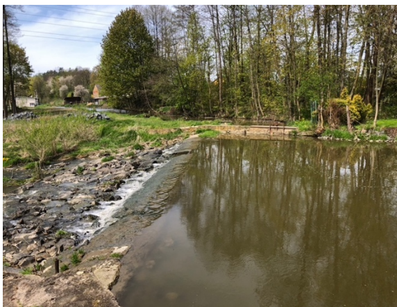
Foto 9 - Rozdělovací objekt pod Vavříneckým r.
