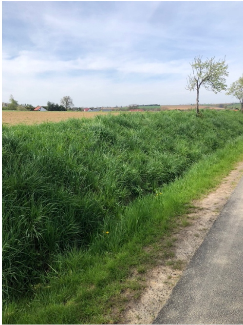
Foto 28 - Příkop zajišťující odvodnění pozemku
