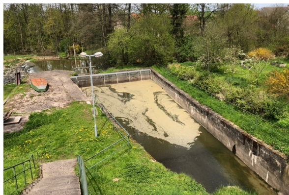
Foto 8 - Soutok za vyrovnávací nádrží pod Vavříneckým r.
