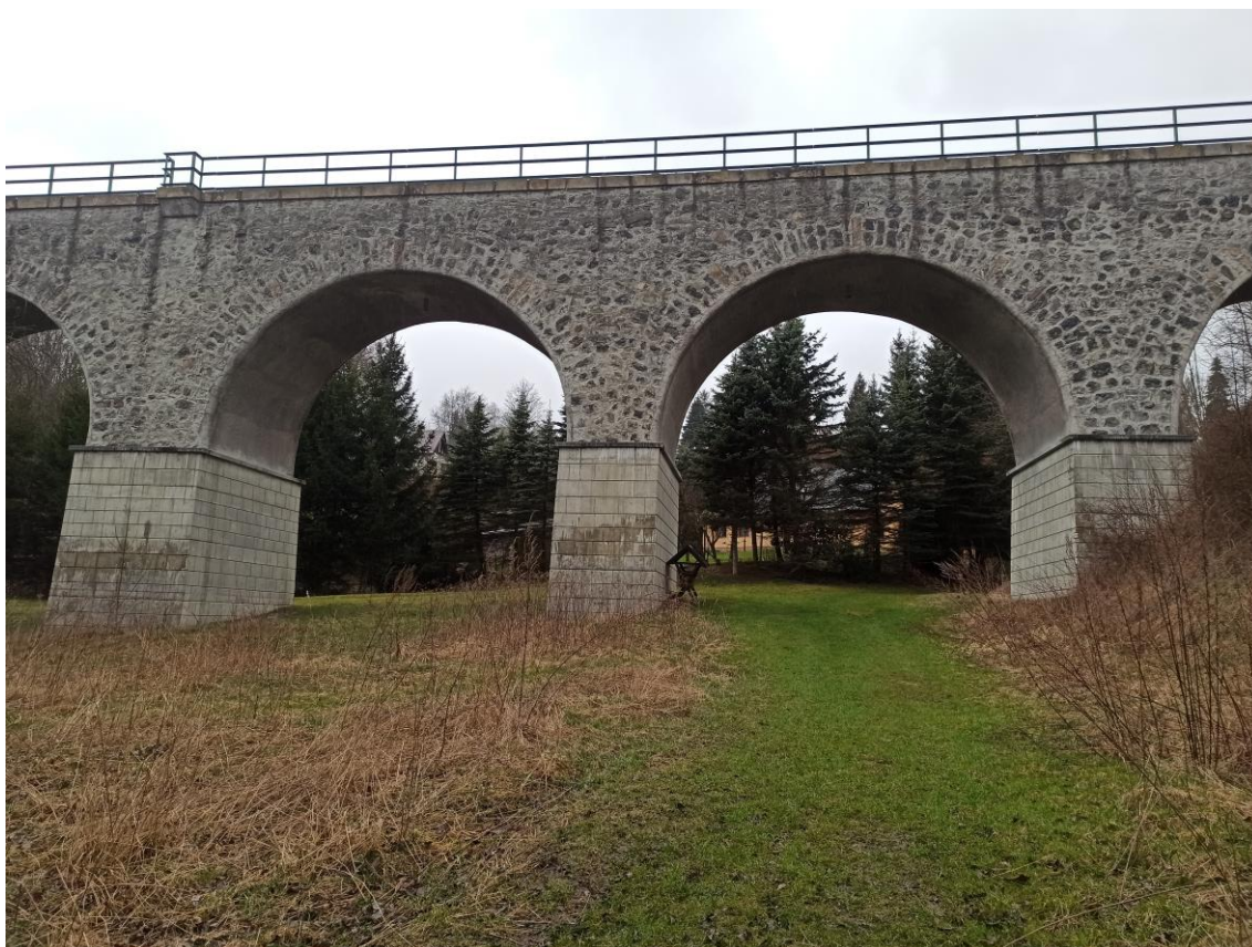
Obr. 19 – Železniční most trati č. 149
