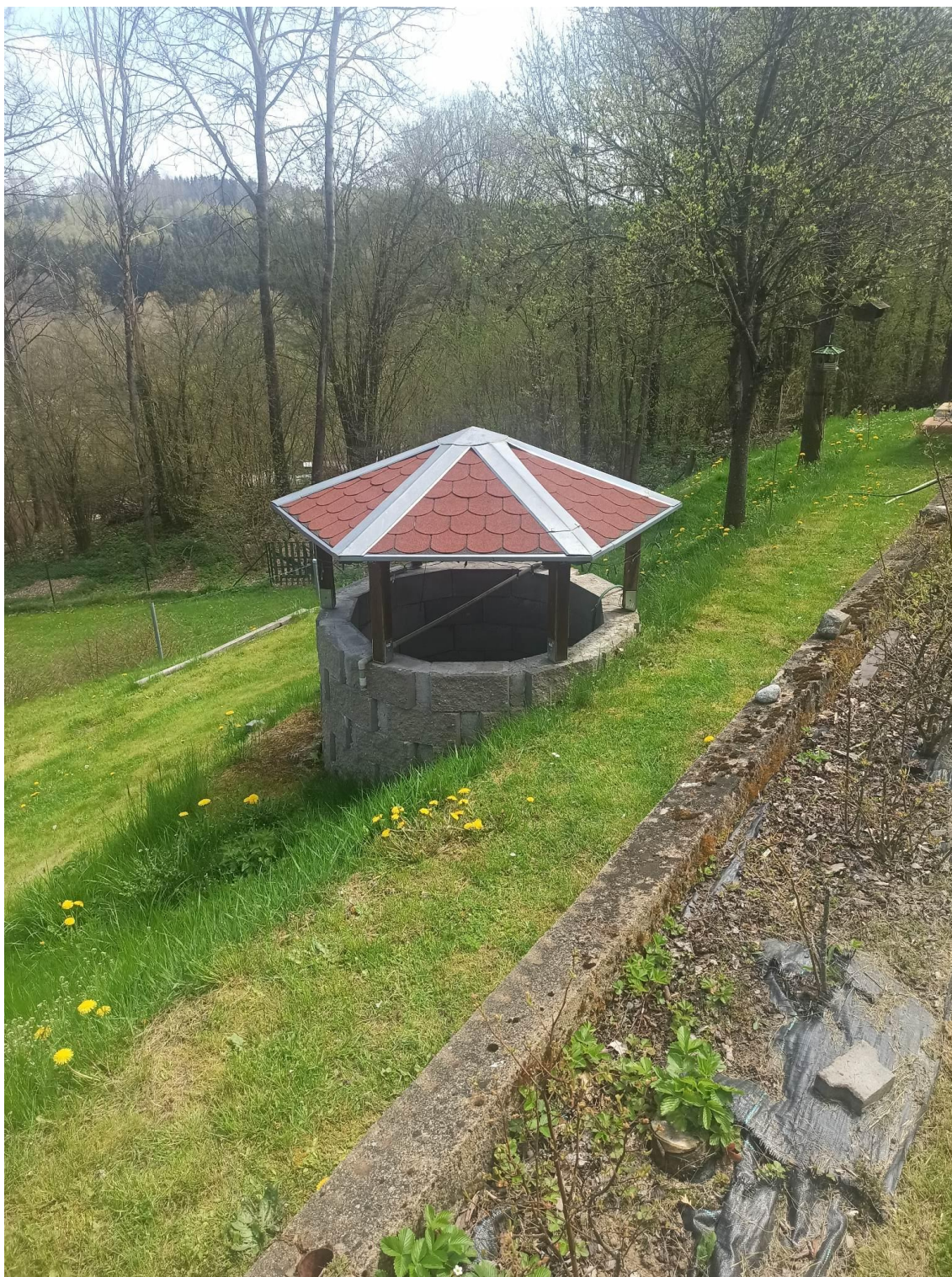
Obr. 29 – Nádrž pro akumulaci dešťových vod odváděných z hlavního objektu na pozemku (RD)
