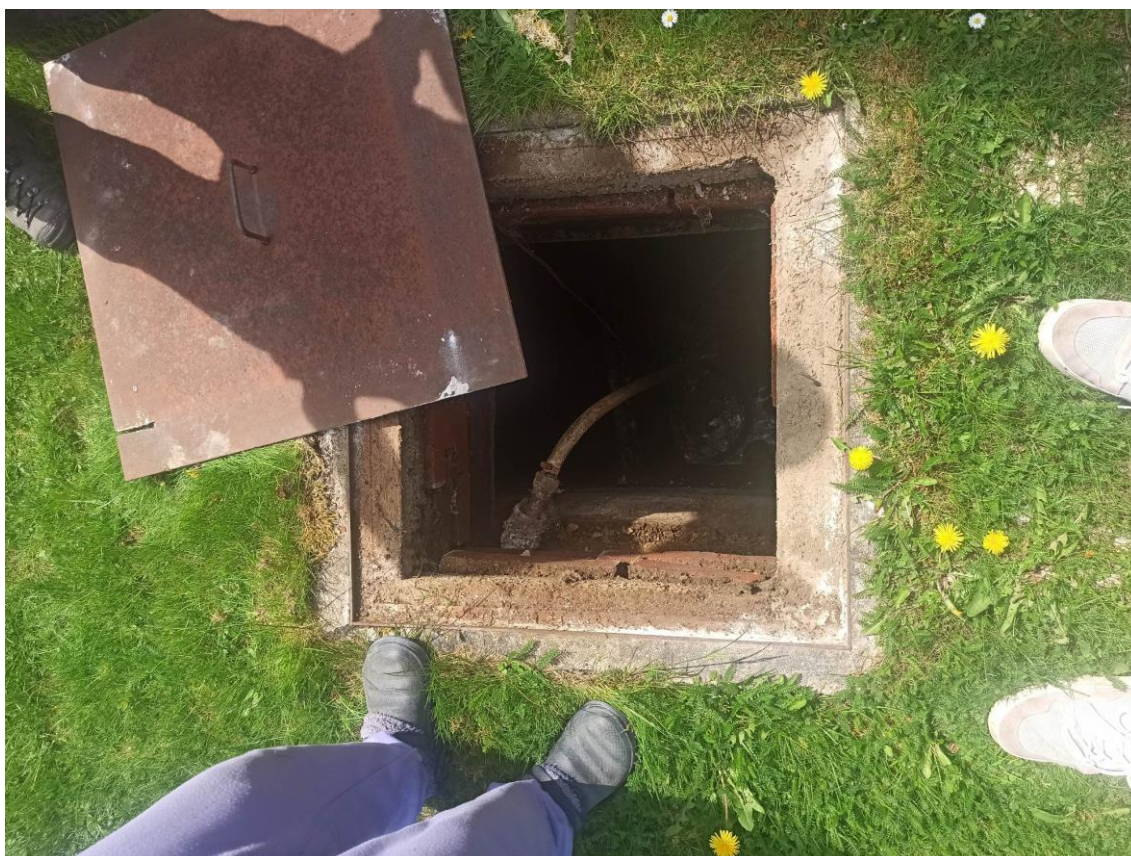
Obr. 27 – Bezodtoká jímka rodinného domu v obci Milhostov
