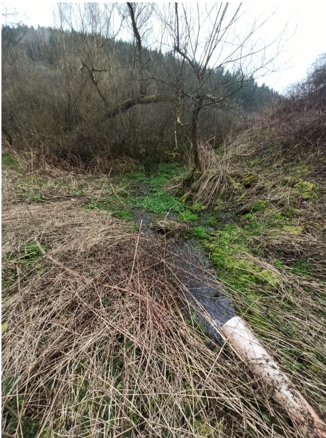
Obr. 32 – Příklad starého, načerno realizovaného svodného potrubí bez dokumentace
