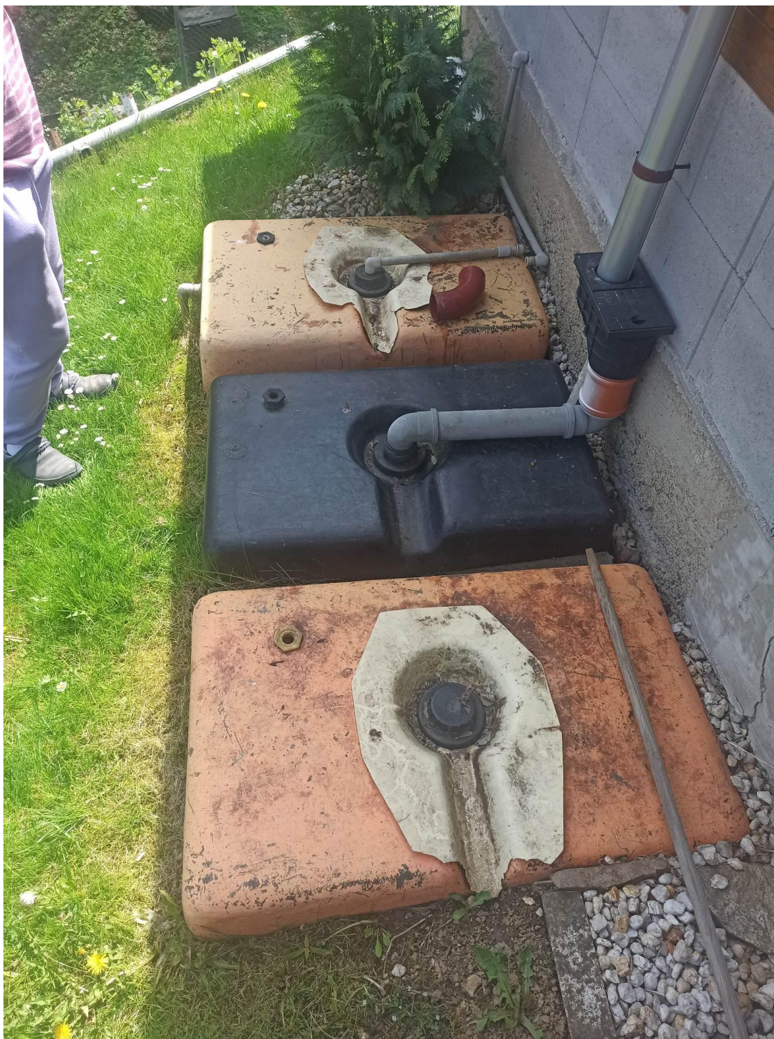
Obr. 30 – Menší nádrže pro akumulaci dešťových vod odváděných z vedlejších objektů na pozemku (garáž, altán)
