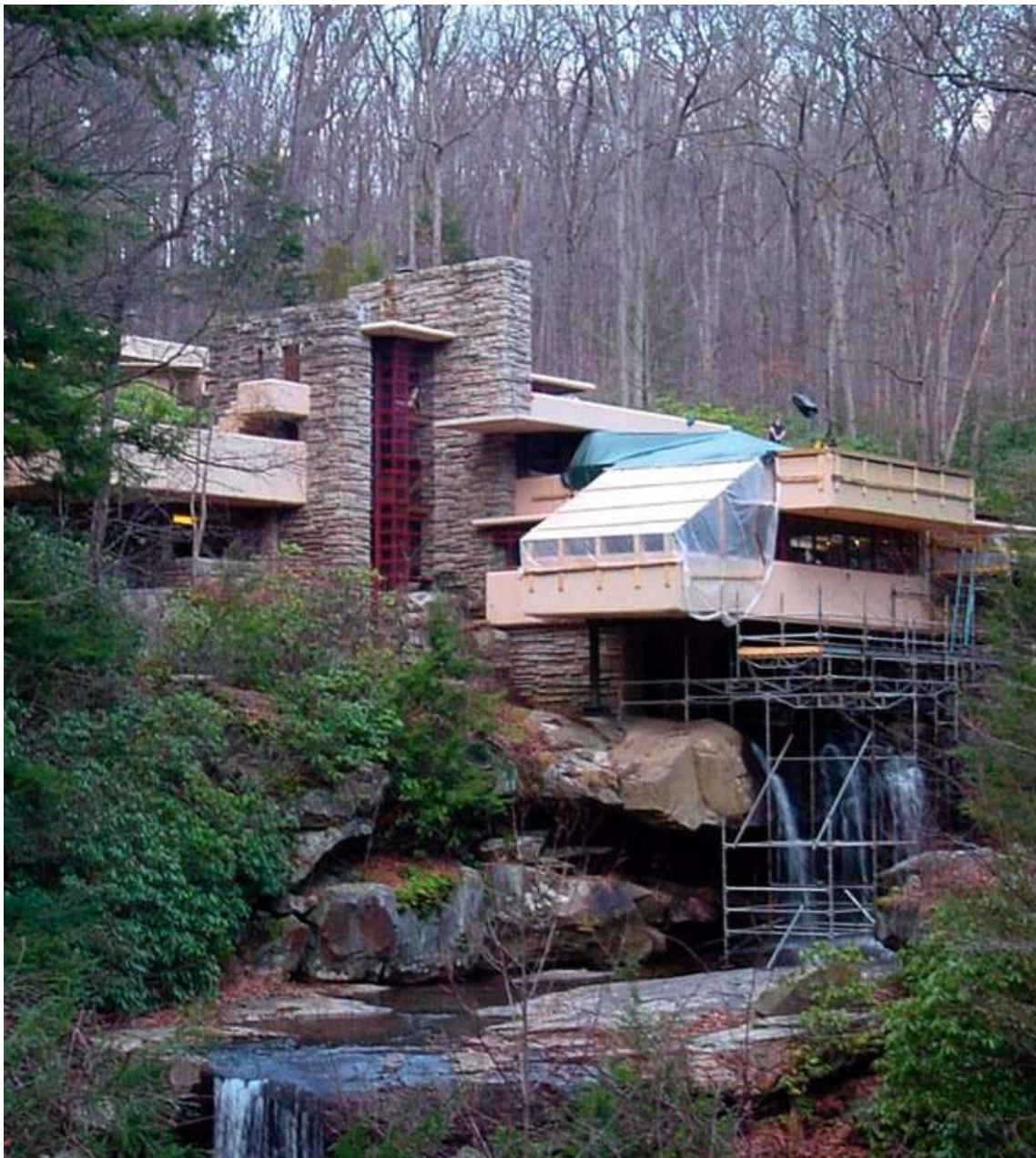
Obrázek 2: Fotografie vily Fallingwater během rekonstrukce [9]
