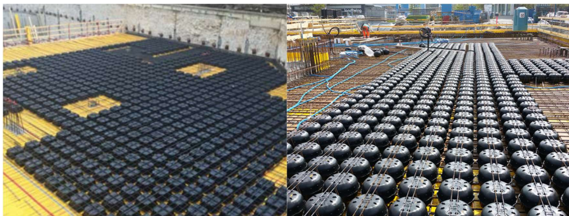
Obrázek 58 a 59: Systém vylehčení monolitické desky U-Boot, Cobiax [8], [7]
