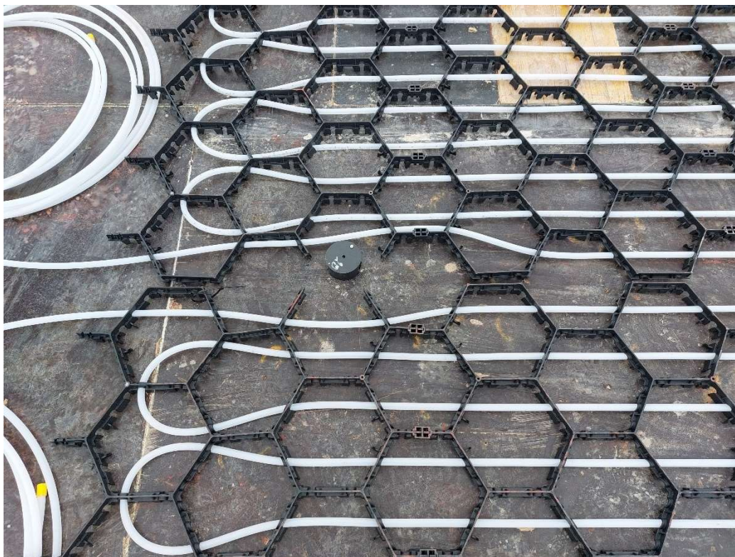
Obr. 7: Ukázka panelu na stavbě
