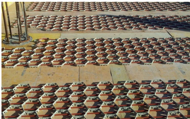
Panely registru Wavin CW-90 položené na desky bednění
