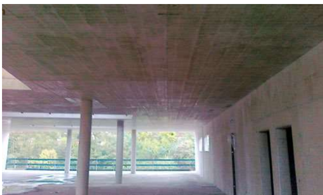
Hotová stropní deska
