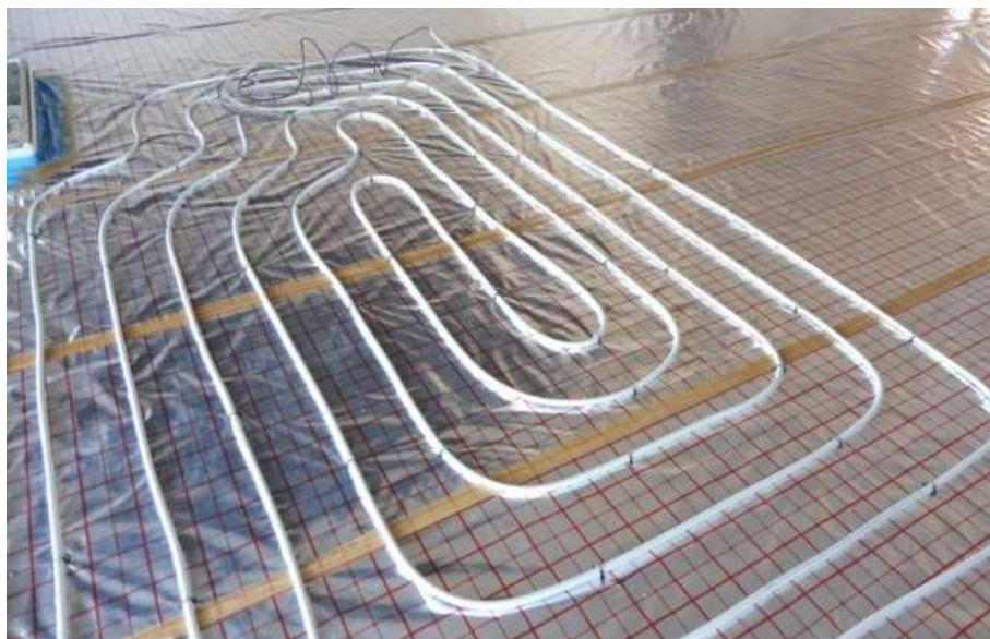
Obr. 6: Montáž podlahového vytápění [15]
