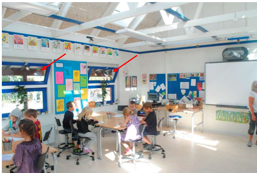
Obrázek 13: Třída s mechanicky otevíratelnými okny v Dánsku [47]
