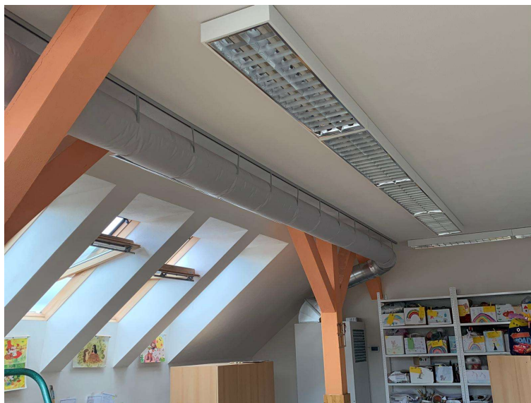
Obrázek 12: Textilní vyústka s dvojitým zavěšením [archiv Příhoda s.r.o.]
