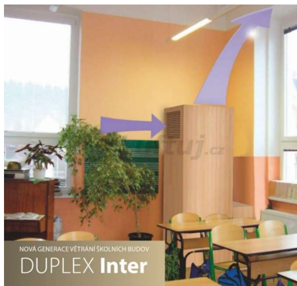
Obrázek 21: Větrací jednotka bez distribučních prvků [58]
