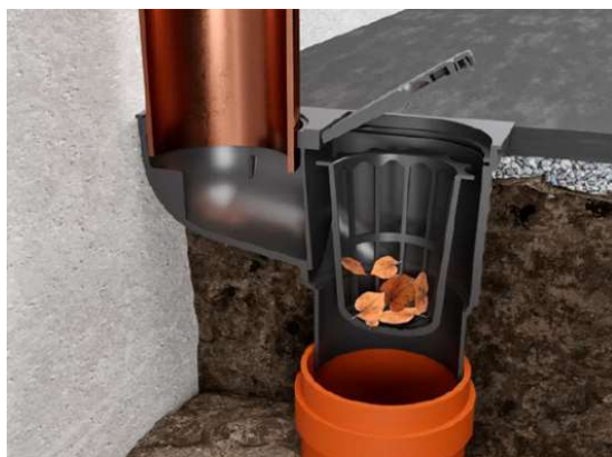
Obrázek 8 – Lapač střešních splavenin [18]
