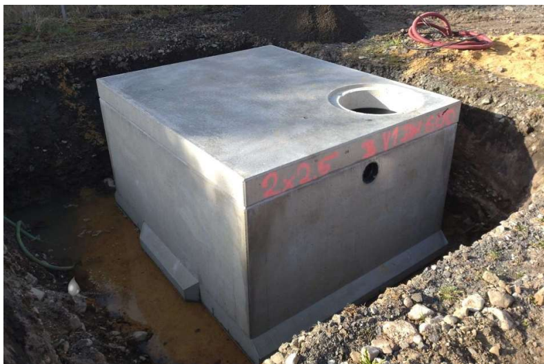
Obrázek 16 – Prefabrikovaná betonová nádrž [30]
