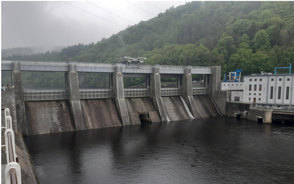
Obr.3. 1: Pohled na dílo ze zdi plavební komory
