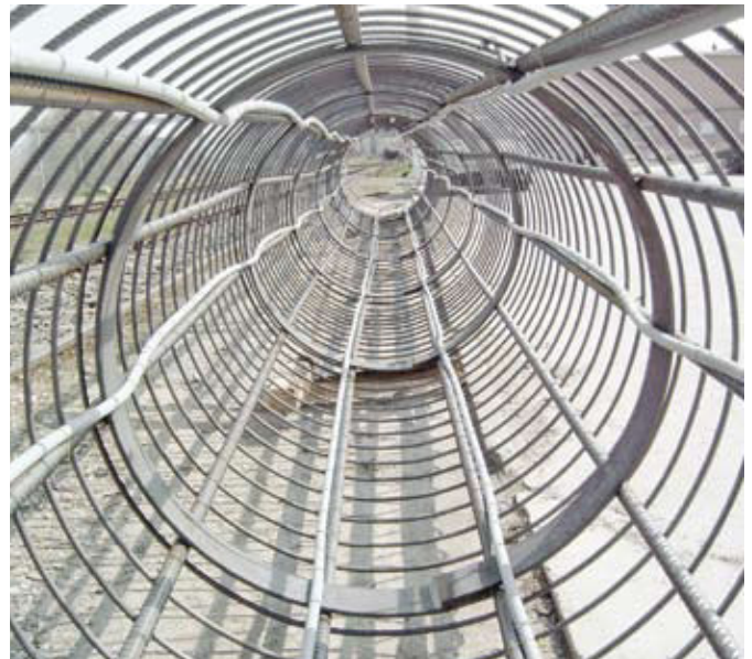
Obr. 15: Trubky RAUGEO collect PE-Xa montované v armovacím koši
