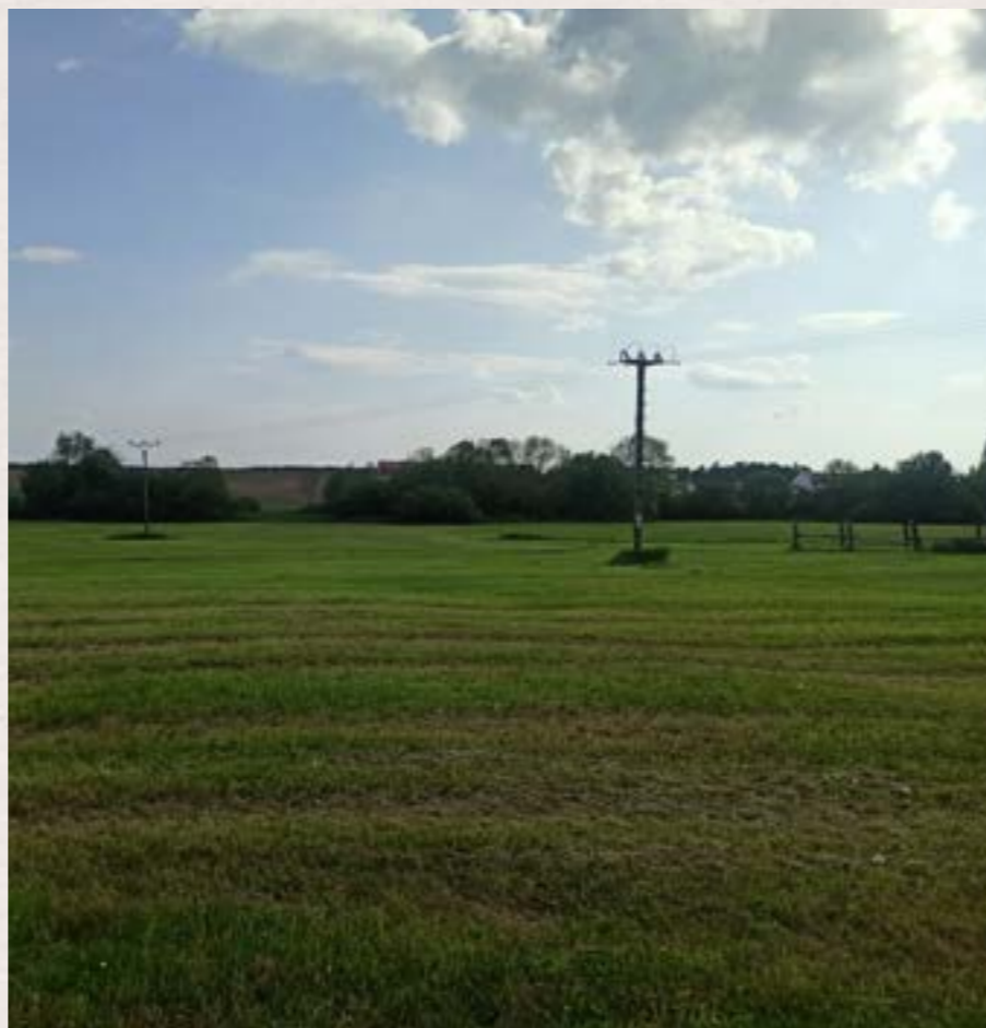
04 - POHLED OD TRAFOSTANICE
