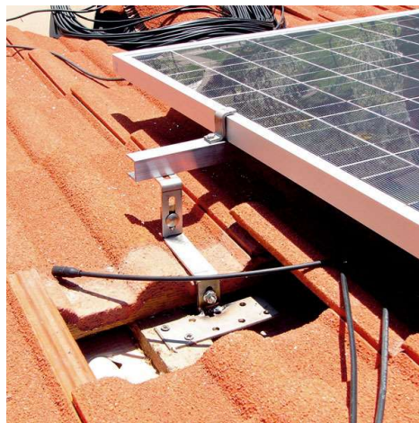
Obrázek 7: Instalace fotovoltaických panelů na šikmou střechu převzato z [14]
