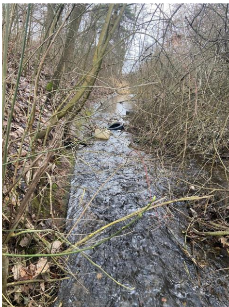
Obrázek 5: Opevněné koryto Jesenčanského potoka (ř.km 2.610)
