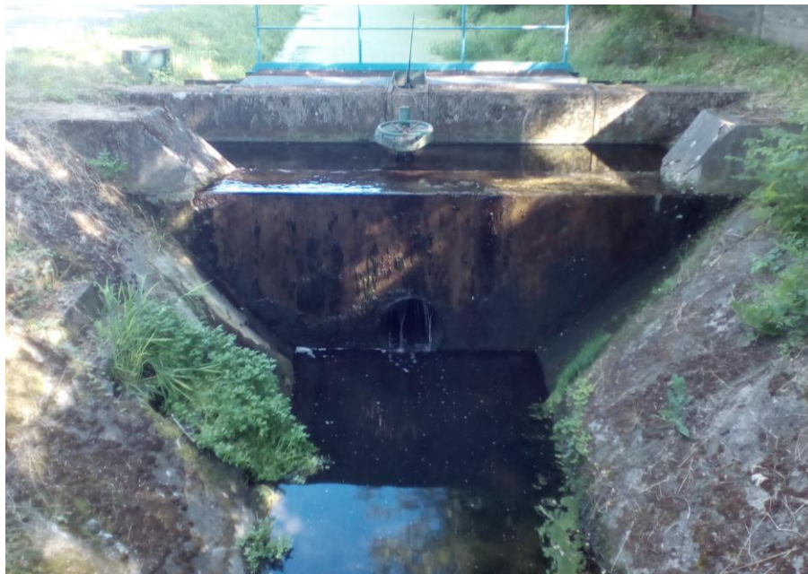
Obrázek 12: Regulační objekt (ř.km 1.219) [21]
