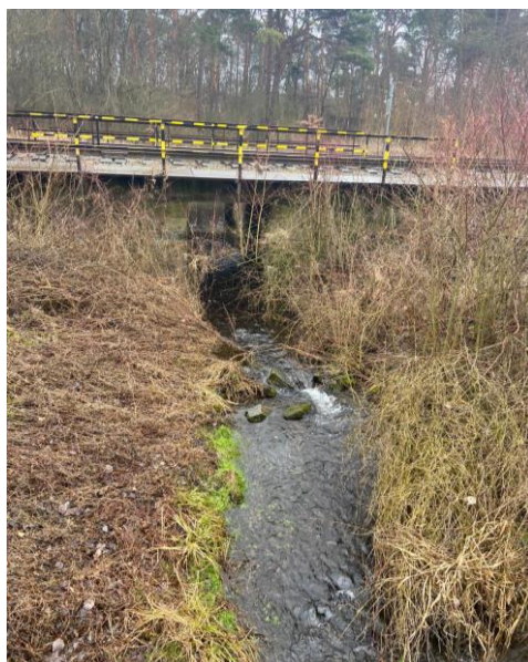
Obrázek 4: Úsek mezi dvěma železničními mosty (ř.km 2.639)
