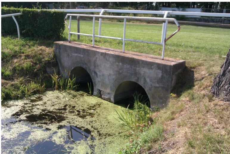
Obrázek 9: Kruhový propustek na dostihovém závodišti (ř.km 2.026) [21]
