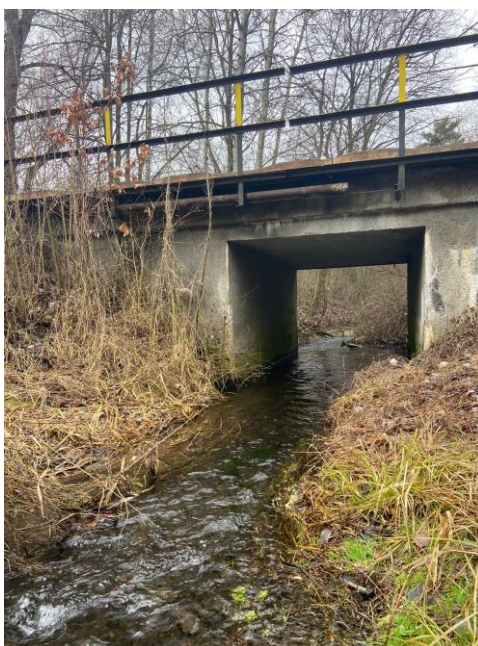
Obrázek 11: Pohled na mostní objekt (ř.km 2.622)
