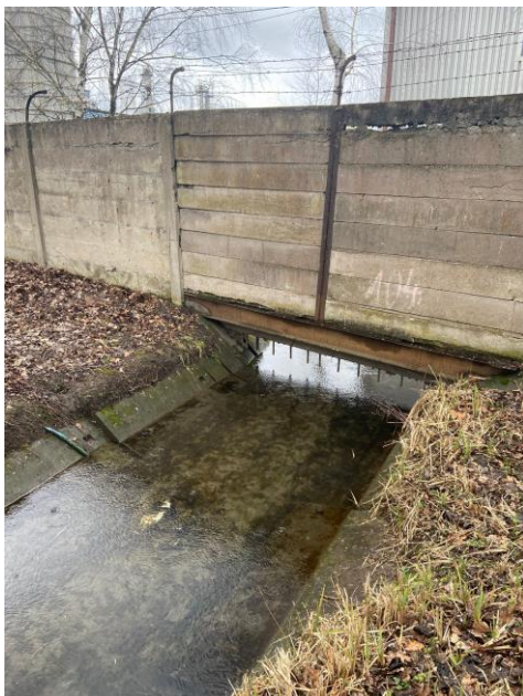
Obrázek 6: Místo vtoku do průmyslového areálu (ř.km 1.950)
