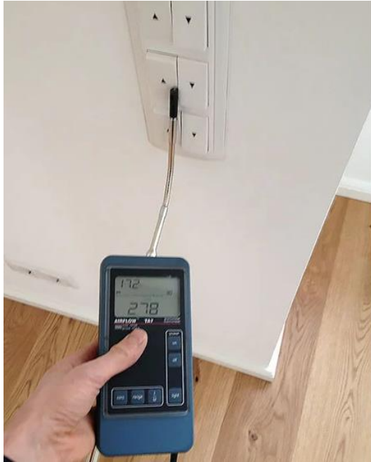
Obrázek 5-Měření vzduchotěsnosti zásuvky pomocí anemometru [6]
