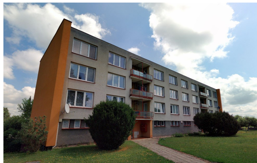
bytový dům (ulice Svěpomoc)
