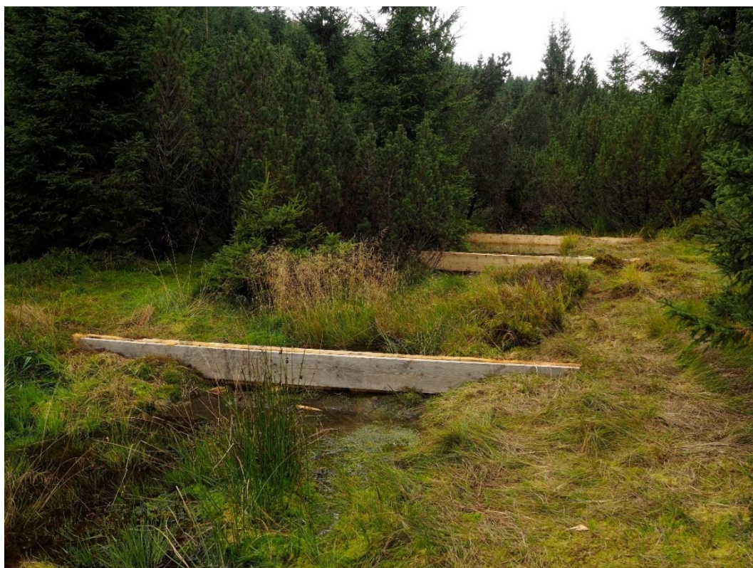
Obrázek 7-18 – nové přehrážky realizované v roce 2022 – západní část OP Rašeliniště Jizery (foto Brůžek 2022)
