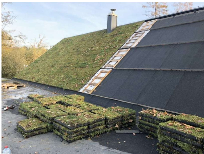
Obrázek č. 4: Realizace strmé zelené střechy [21]
