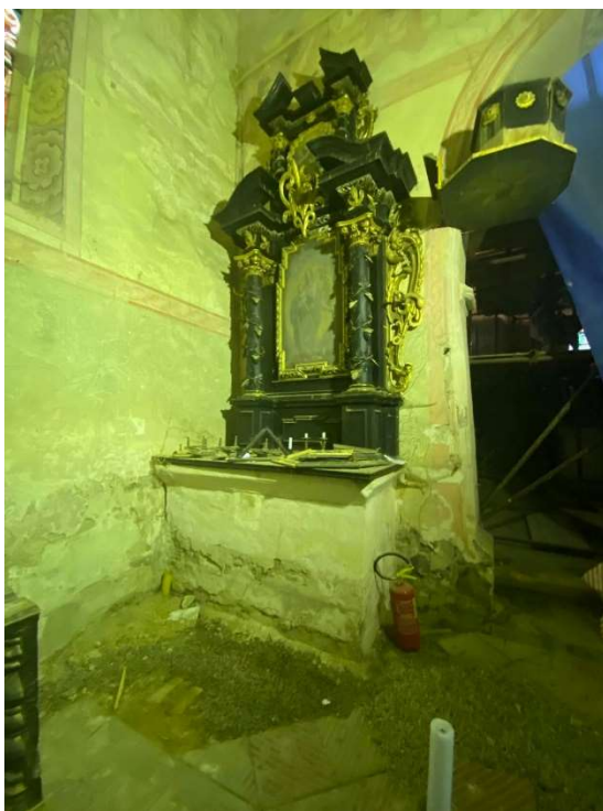
Obrázek 49: Zcela chybějící podlaha u obvodových stěn
