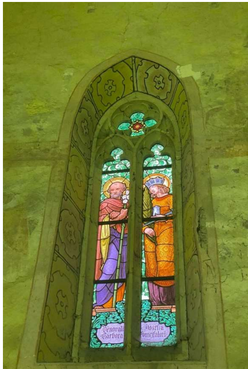
Obrázek 26: Vitrážové okno – jižní stěna
