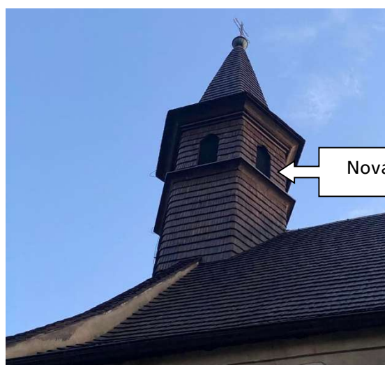
Obrázek 56: Vyměněná okna v rámci obnovy střechy
