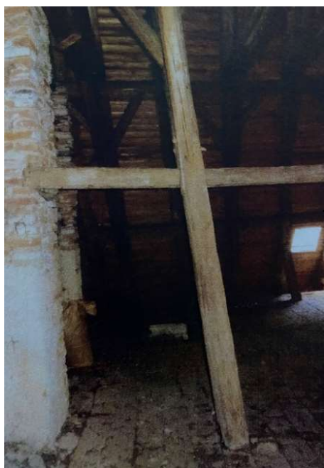
Obrázek 45: Konstrukce krovu – pohled na středový sloupek [archiv]
