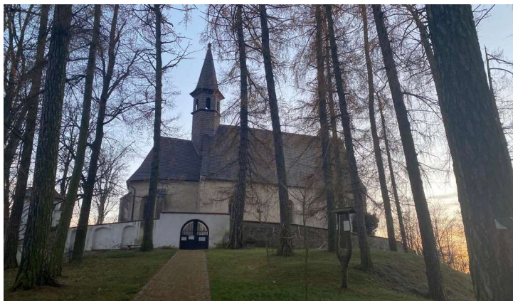
Obrázek 4: Čelní pohled na kostel – severní pohled
