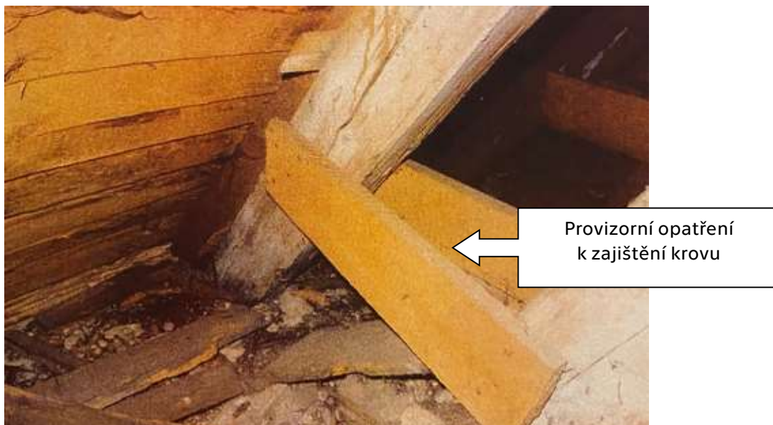
Obrázek 46: Konstrukce krovu [archiv]
