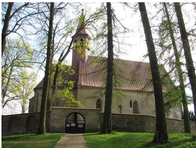
Obrázek 15: Kostel před výměnou střešní krytiny – plechová krytina
