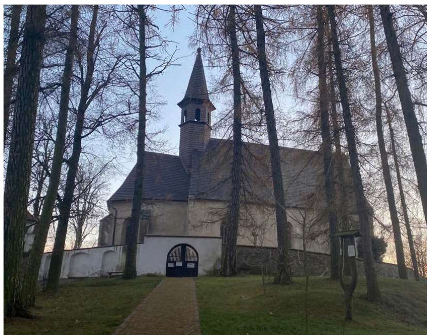
Obrázek 87: Kostel po výměně střešní krytiny – dřevěný šindel
