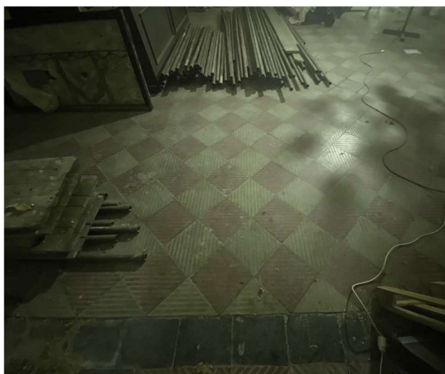
Obrázek 21: Cementová dlažba v interiéru kostela
