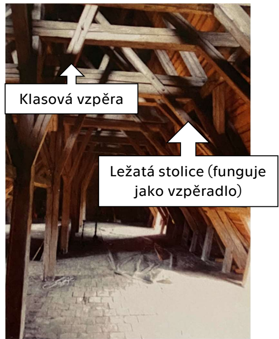
Obrázek 18: Konstrukce krovu [archiv]
