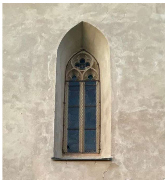
Obrázek 55: Zachovalé vitrážové okno – exteriér
