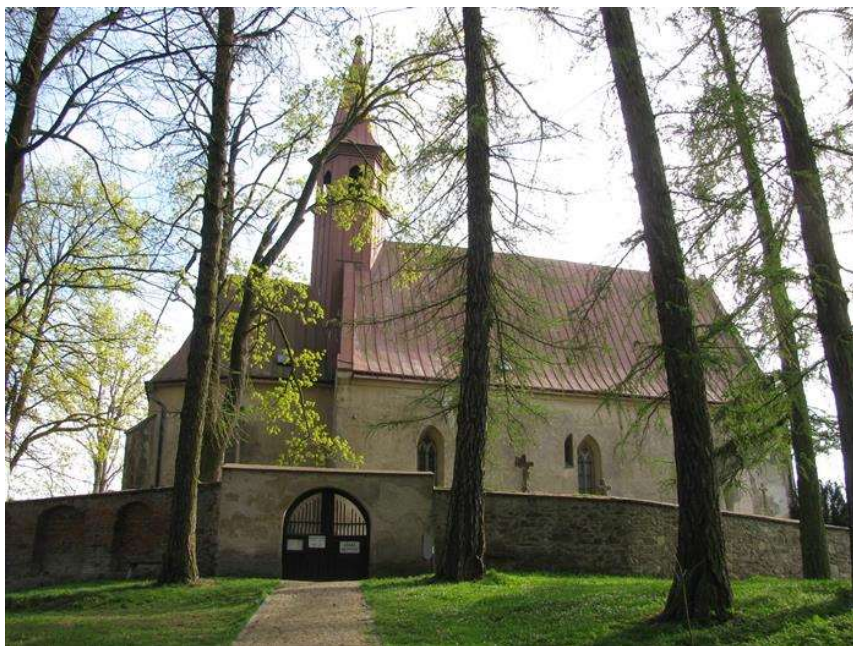
Obrázek 86: Kostel před výměnou střešní krytiny – plechová krytina
