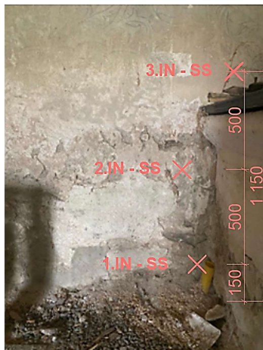
Obrázek 61: Interiér – severní stěna
