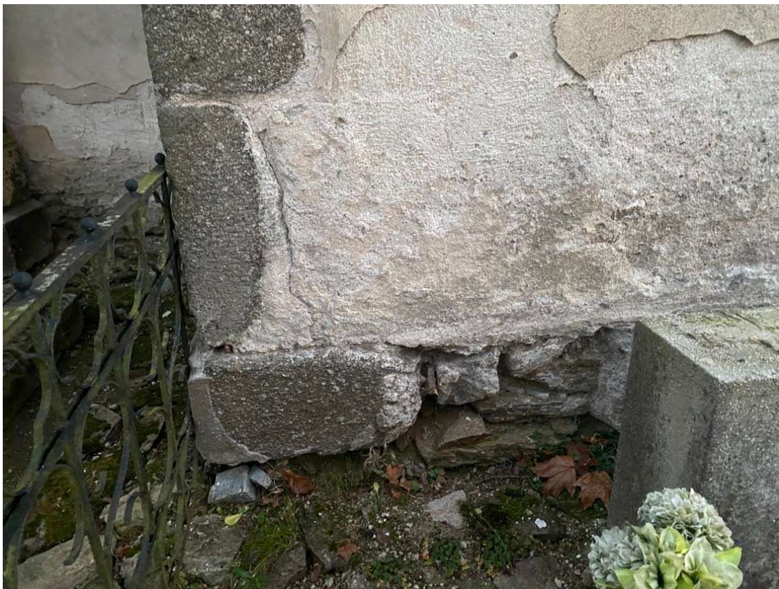
Obrázek 12: Kamenné obvodové zdivo kostela
