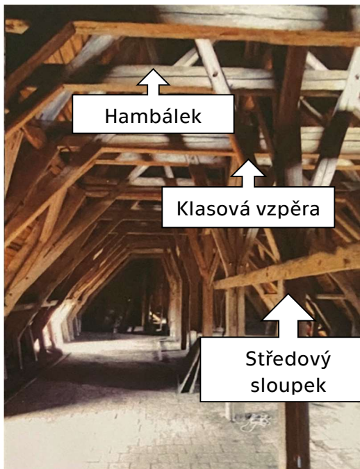
Obrázek 17: Konstrukce krovu [archiv]
