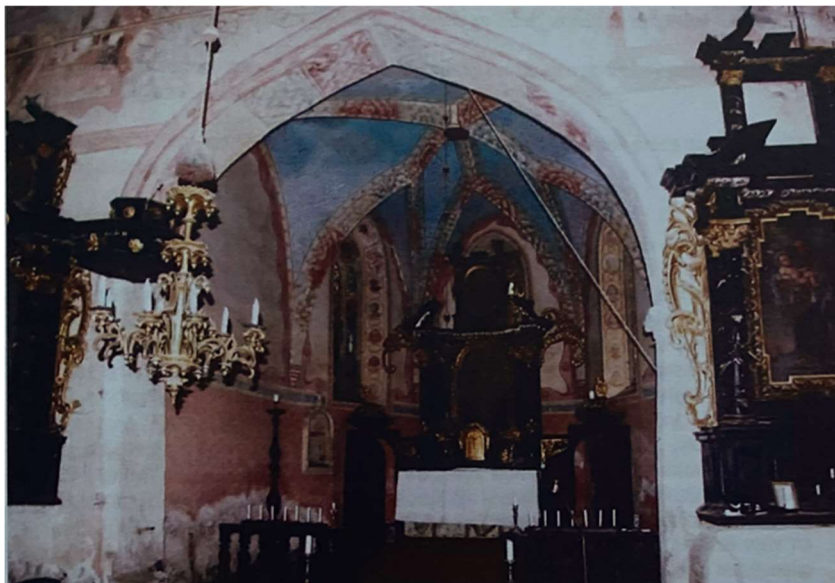
Obrázek 13: Křížová klenba nad presbyteriem a vítězný oblouk [archiv]
