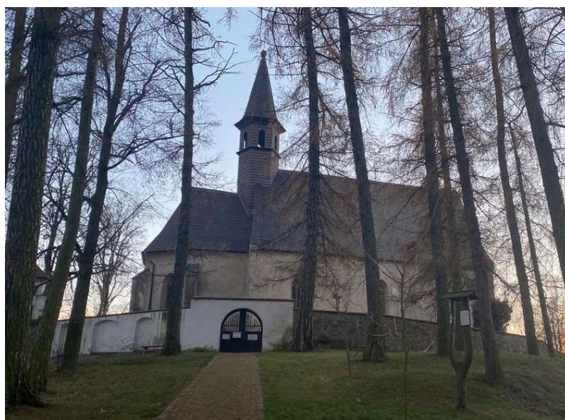
Obrázek 16: Kostel po výměně střešní krytiny – dřevěný šindel
