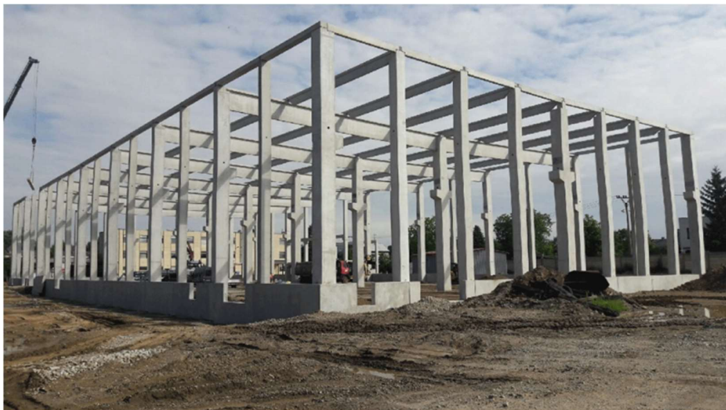
Obr. 1.1: Příklad prefabrikované konstrukce s konzolami [10]
