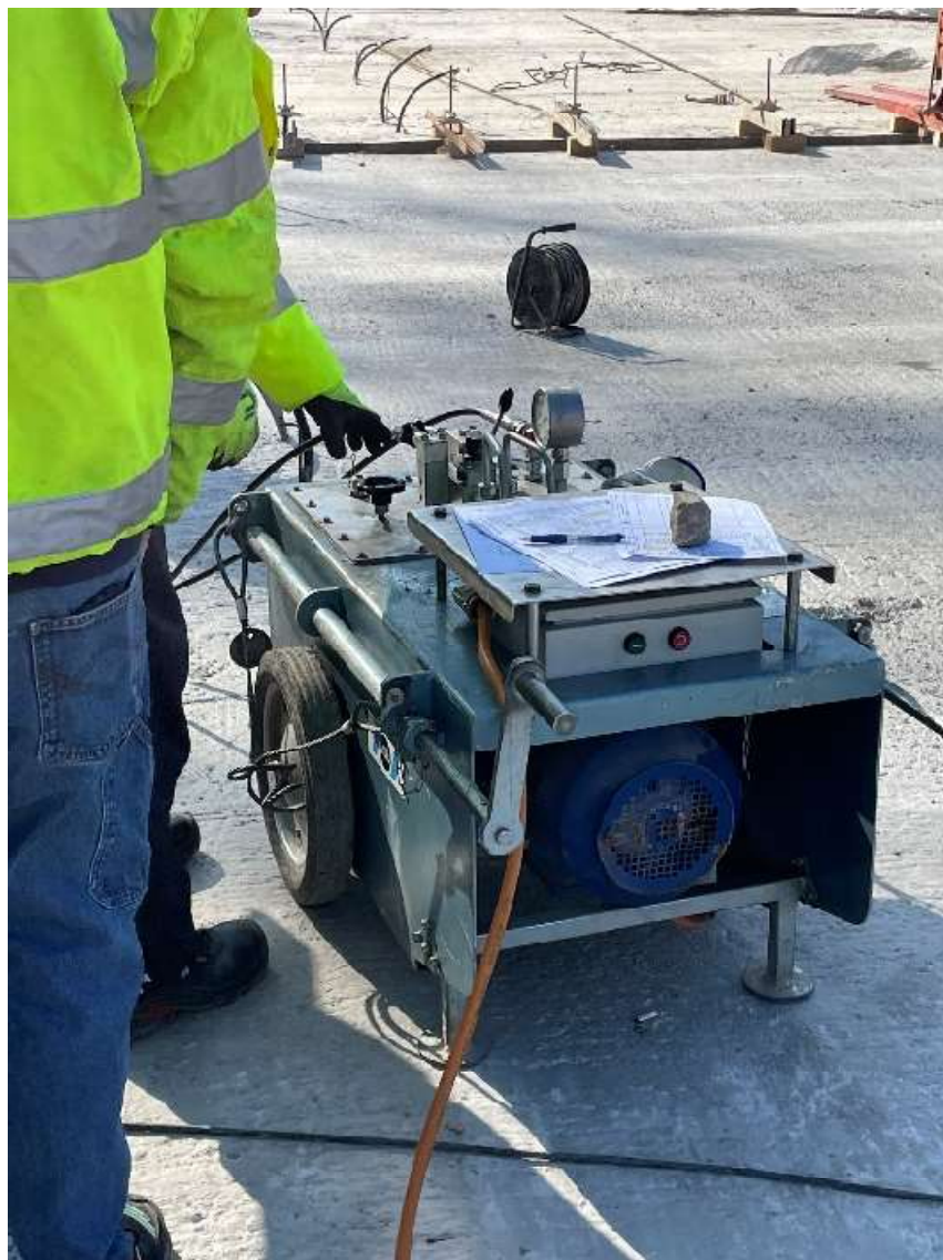
Obrázek 20 Zařízení pro předpínání
