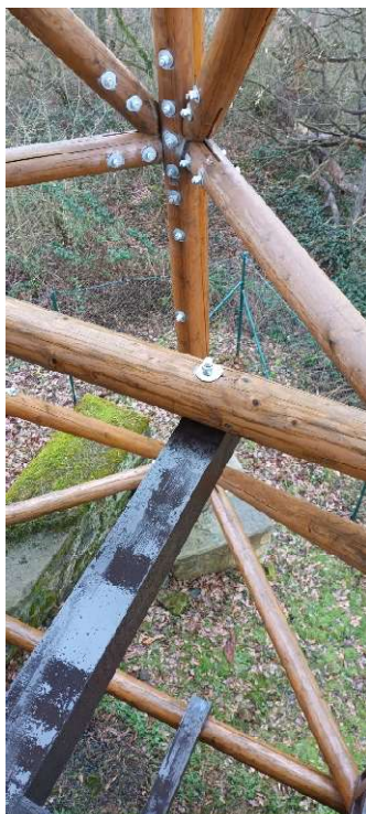
Obrázek 6 Detail přípoje schodiště
