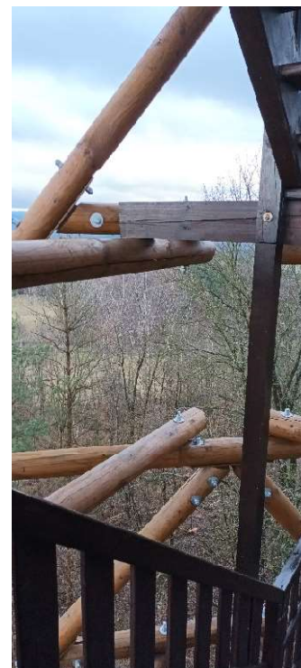
Obrázek 7 Detail přípoje schodiště
