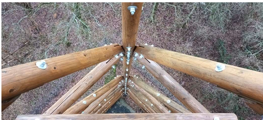
Obrázek 4 Detail styčnicku nárožníku, nosníku a diagonály
