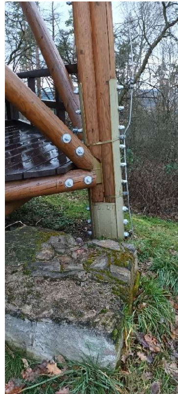
Obrázek 9 Detail kotvení
