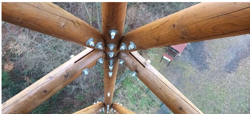
Obrázek 28 Přípoj nárožník-nosník-diagonála
