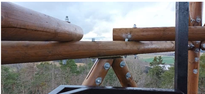
Obrázek 3 Detail styčnicku diagonály a nosníku
