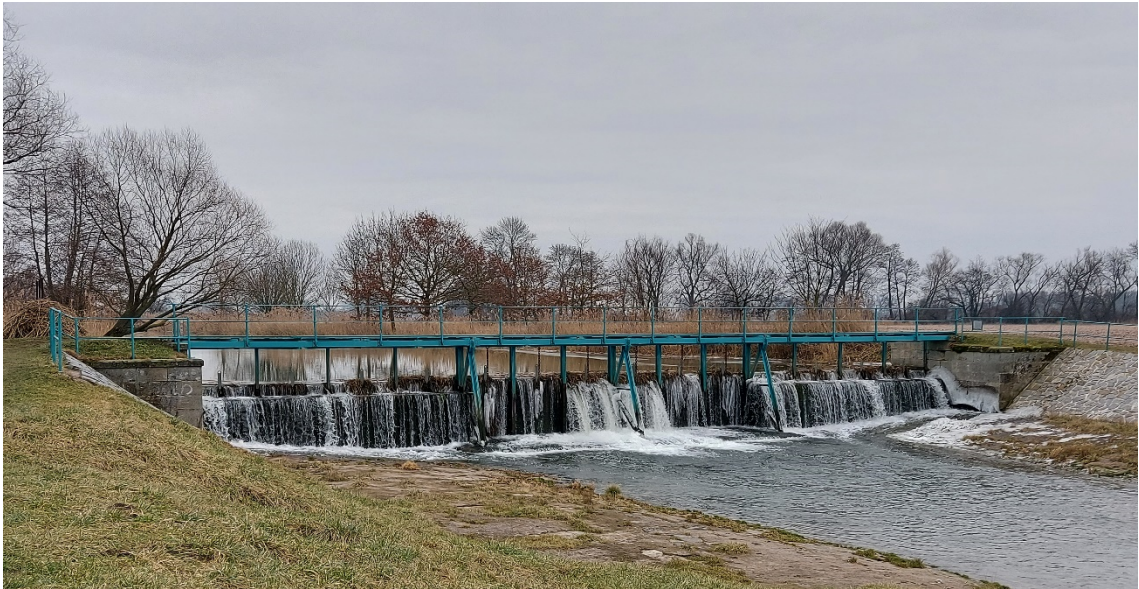
Foto č. 1: Celkový pohled na jez
