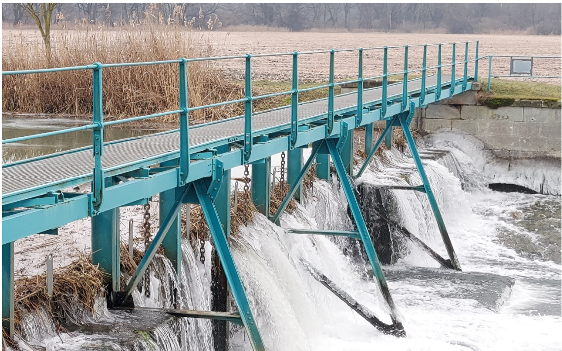
Foto č. 2: Pohled na střední část jezu
