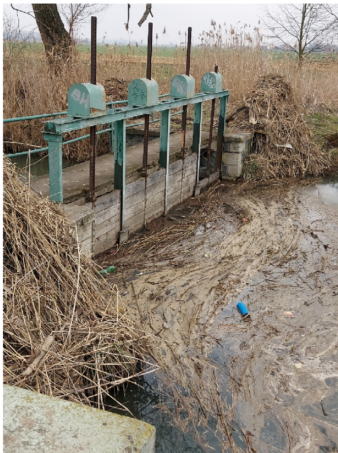
Foto č. 5: Pohled na vtokový objekt náhonu
