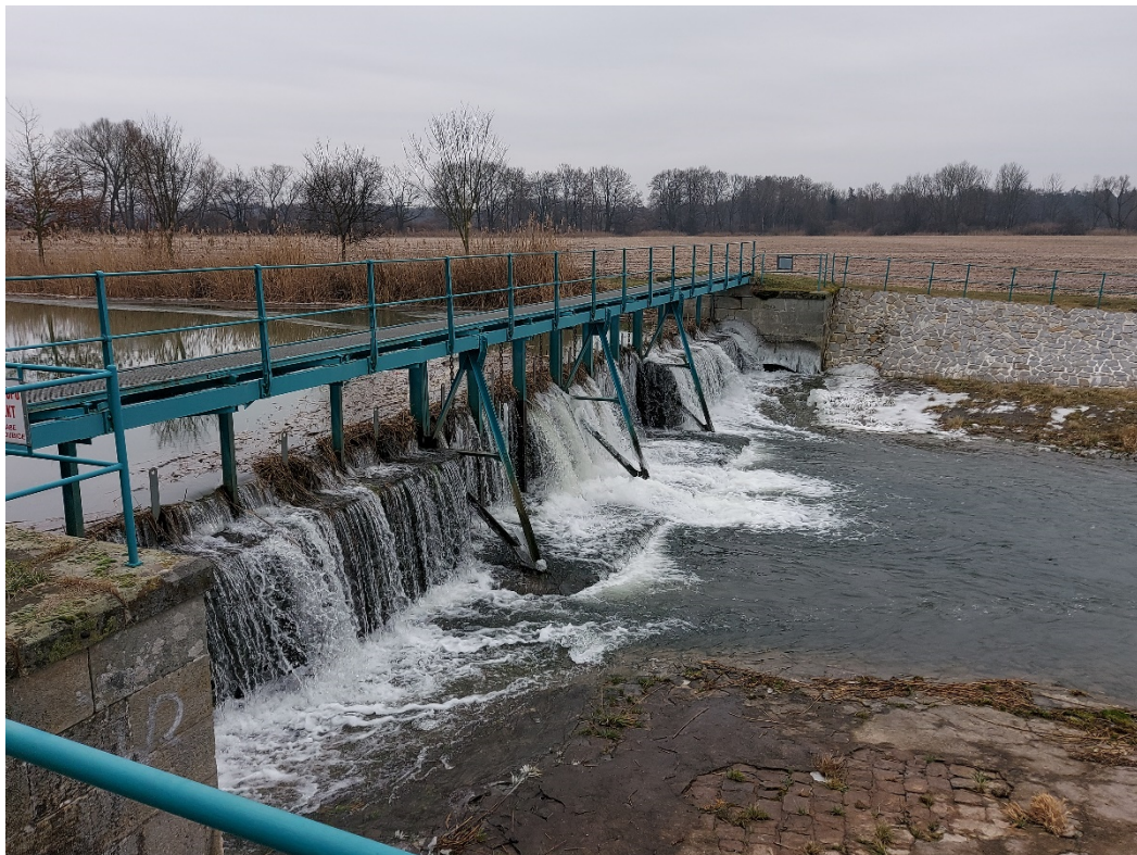
Foto č. 7: Pohled na podjezí
