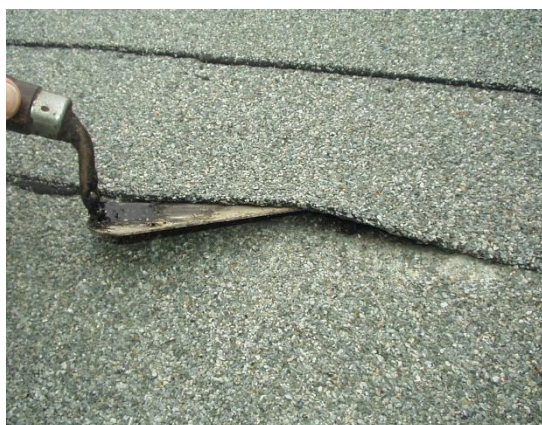
Obr. 53 - Příklad necelistvého sváru [65]
