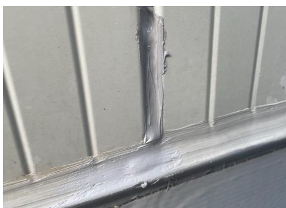
Obr. 66 - Zapravení spáry pomocí tmelu (foto autor)
