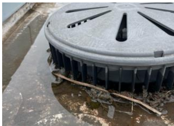
Obr. 74 - Zanesení střešního vtoku (foto autor)
