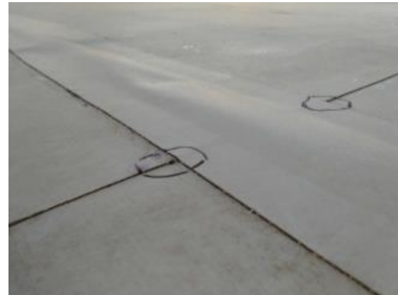
Obr. 80 - Označení netěsností
