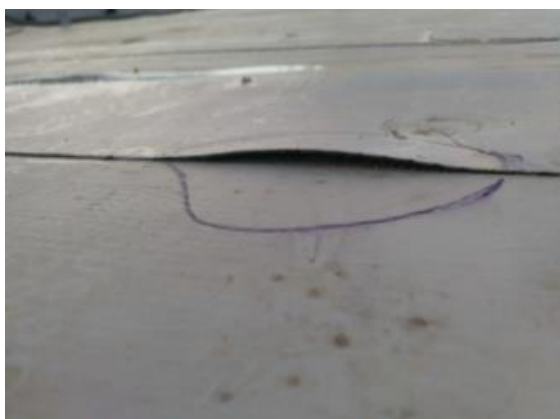
Obr. 81 - Označení netěsností
