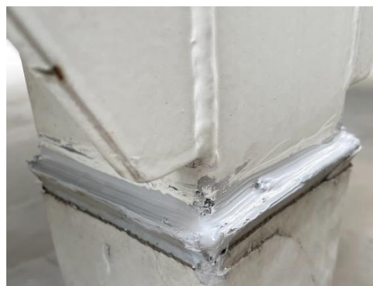
Obr. 72 - Oprava spáry přetmelením (foto autor)
