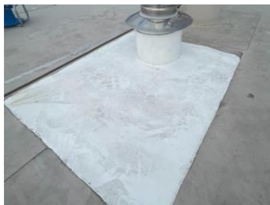
Obr. 58 - Následná oprava hydroizolace (foto autor)
