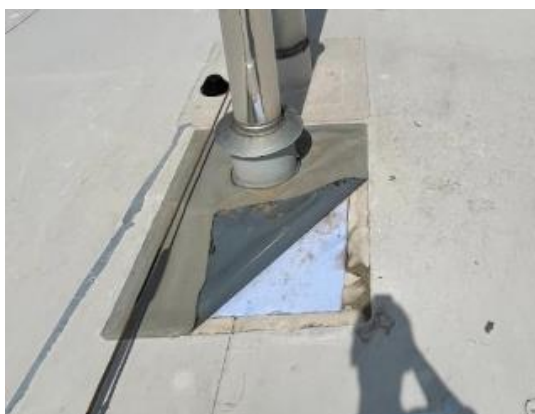
Obr. 57 - Nesoudržné napojení (foto autor)
