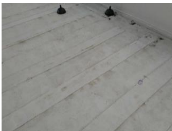
Obr. 79 - Označení netěsností
