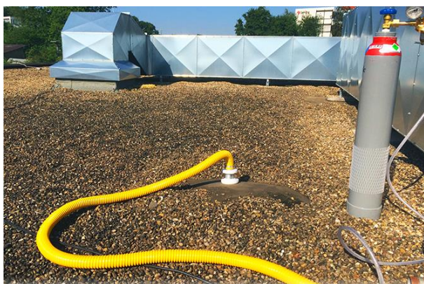
Obr. 36 – Napojení pod vrstvu hydroizolace [47]
