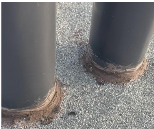
Obr- 67 - Přetmelení přechodu prostupu a hydroizolace (foto autor)
