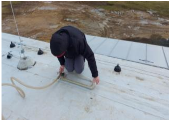
Obr. 77 – Pohled na provádění metody
