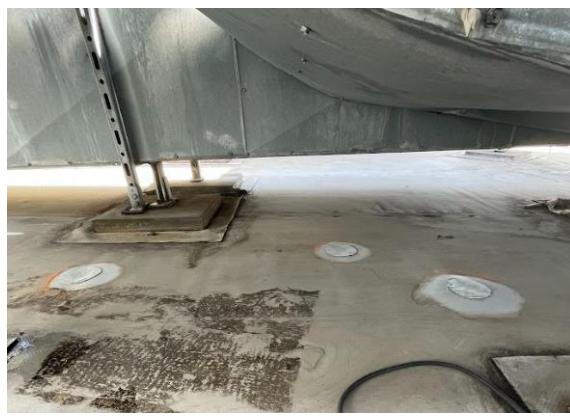
Obr. 62 - Oprava nalezených defektů (foto autor)
