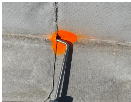
Obr. 54 - Příklad nálezu netěsnosti (foto autor)
