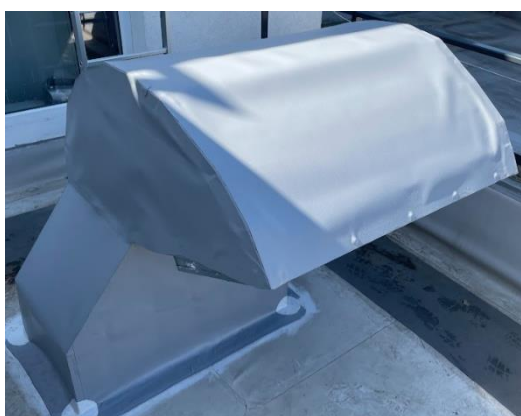
Obr. 65 - Opracování VZT prostupu (foto autor)
