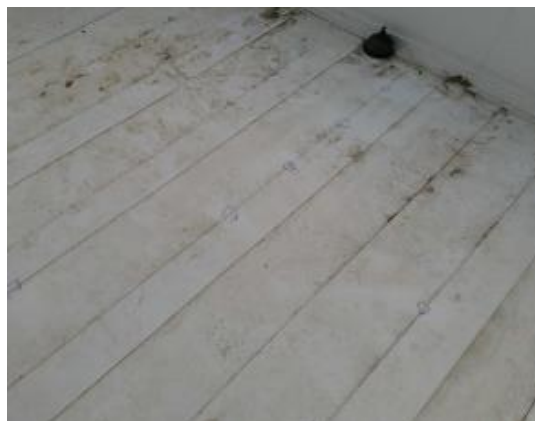
Obr. 76 - Pohled na přeplátované spoje
