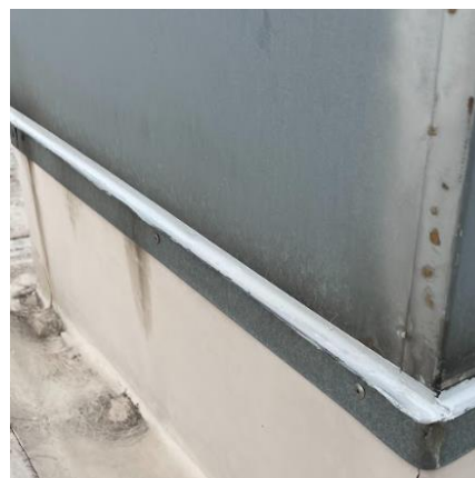
Obr. 70 - Oprava spáry přetmelením (foto autor)
