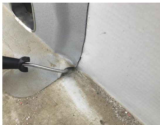
Obr. 10 - Příklad nesoudržného spoje [18]
