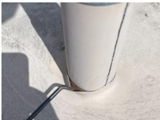
Obr. 55 - Nesoudržné napojení (foto autor)
