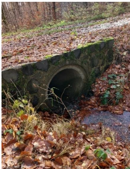
Obrázek 11 – propustek ř. km 2,183 zdroj: autorská fotografie
