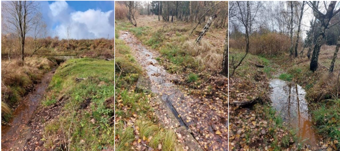
Obrázek 5 - hráz Cihlářského rybníka zdroj: autorská fotografie
