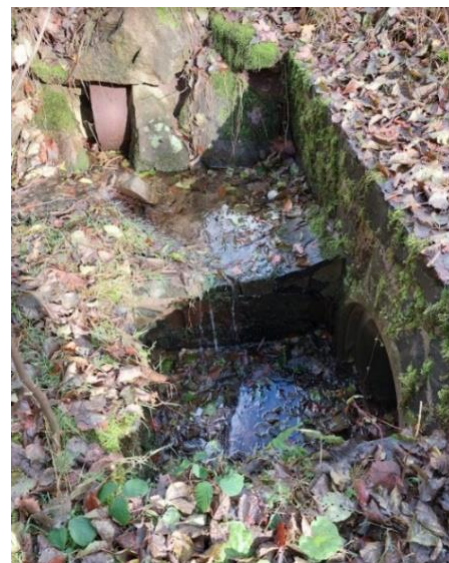
Obrázek 12 – propustek ř. km 1,731 zdroj: autorská fotografie
