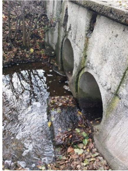
Obrázek 16 – propustek ř. km 0,437 zdroj: autorská fotografie
