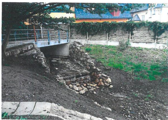
Obrázek 34 – Rybník u Zámku, stabilizační práh 28.6.2017 zdroj: PD Fotodokumentace [16]
