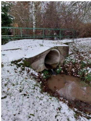
Obrázek 21 – propustek DN 1100 zdroj: autorská fotografie
