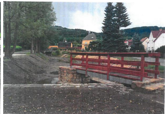
Obrázek 33 – Rybník u Zámku při rekonstrukci 28.6.2017 zdroj: PD Fotodokumentace [16]
