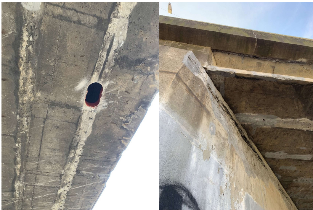
Obrázek 2-12 Vrtaný vstup pro odstranění usazené vody v nosníku (vlevo)
