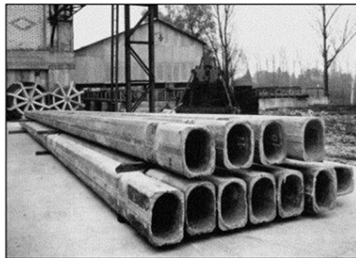
Obrázek 2-1 Historicky první prefabrikované, předem předepnuté prvky z betonu
