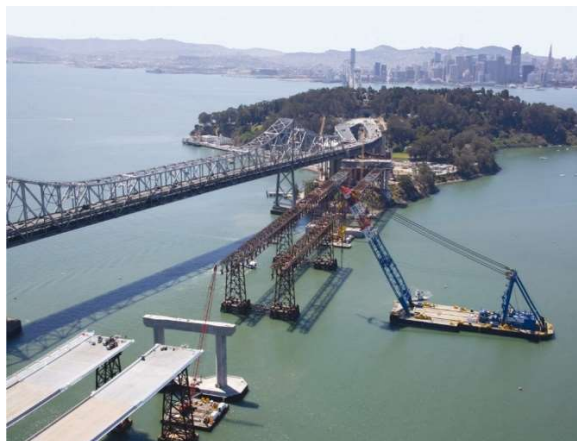
Obrázek 2-18 Výstavba Oakland Bay Bridge
