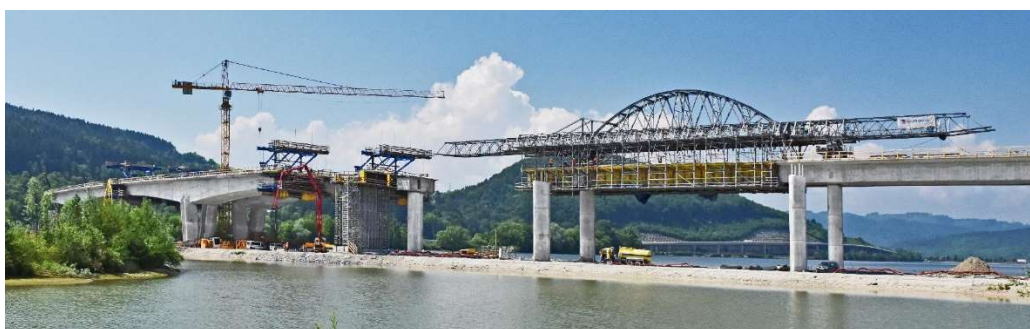
Obrázek 3-4 Příklad posuvné skruže
