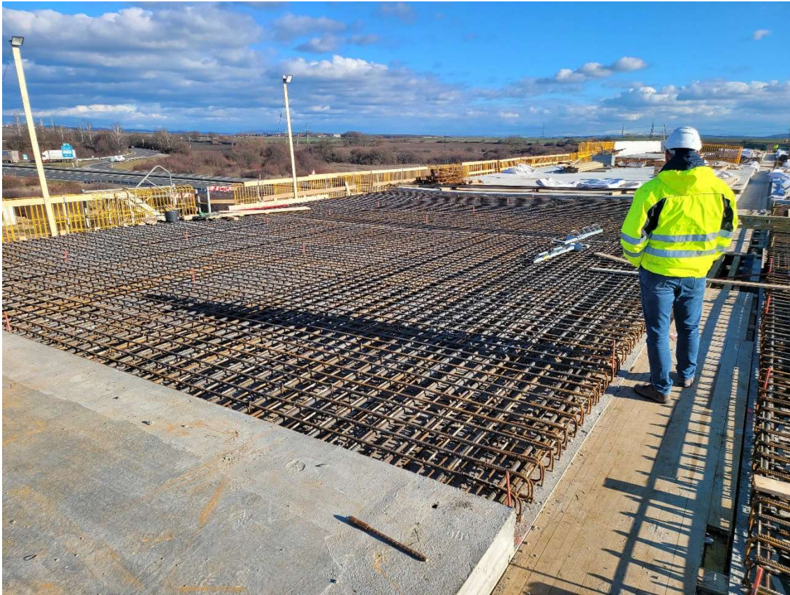
Obrázek 4-10 Foto po betonáži desky
