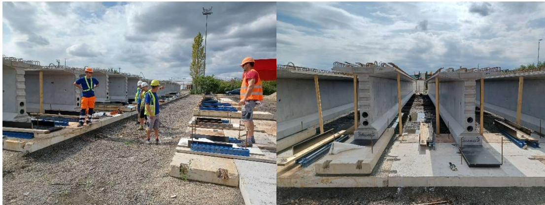
Obrázek 2-22 Deponie nosníku na staveništi pro dodatečné předpětí
