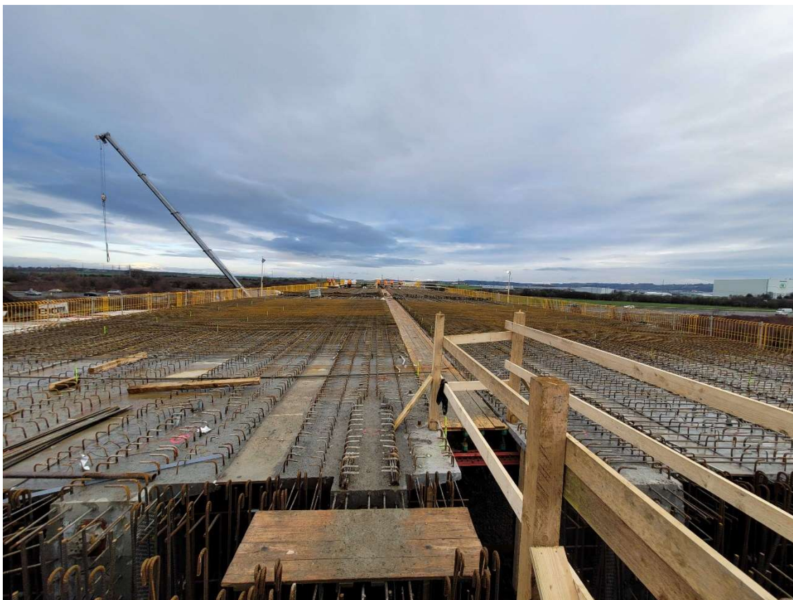
Obrázek 4-9 Horní plocha nosníků po uzpůsobení rpo montáž
