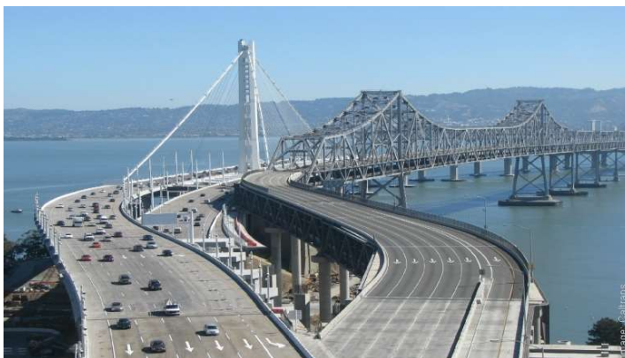
Obrázek 2-17 Oakland Bay Bridge
