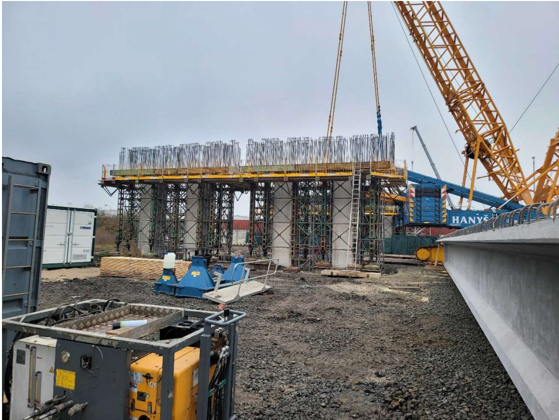
Obrázek 4-5 Osazování prefabrikované části příčniku jeřábem
