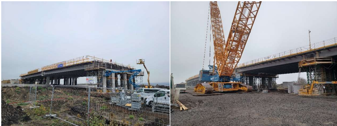
Obrázek 4-6 Fotografie z osazování nosníku na stavbě Most Laurina a Klementa Škoda Auto
