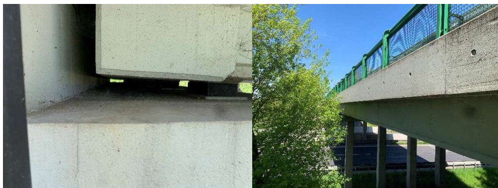
Obrázek 2-9 (vlevo) Příčnick nad podporou, Obrázek 2-10 (vpravo) Pohled na most z boku
