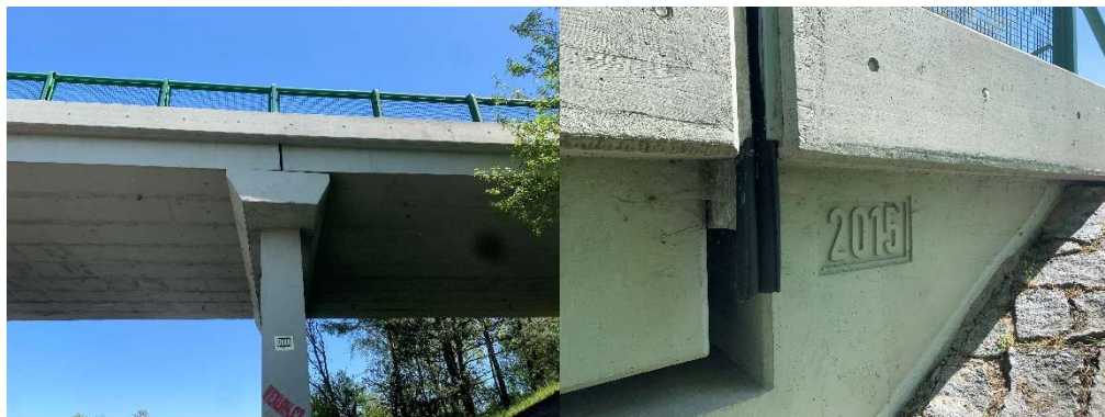
Obrázek 2-7 (vlevo) Pohled na spojení prefabrikátů nad podporou, Obrázek 2-8 (vpravo) Výlisek roku výstavby
