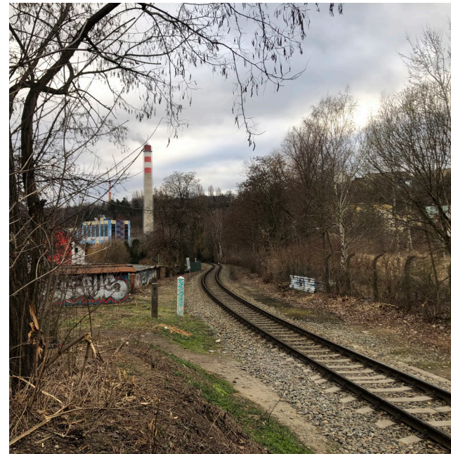
vedení železniční dráhy na severním okraji řešeného území. pohled na funkční plynovou teplárnu
