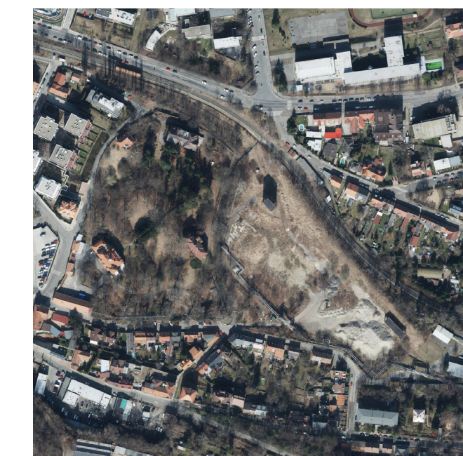
Ortofoto mapa současného stavu, rok 2022. Pozůstatky uhelné teplárny - uhelné silo, uhelný bunkr.
