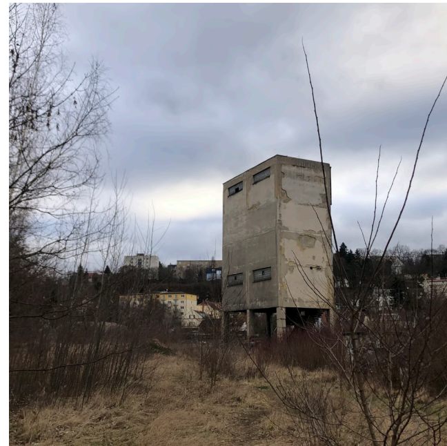
pohled na objekt uhelného sila ze severu řešeného území
