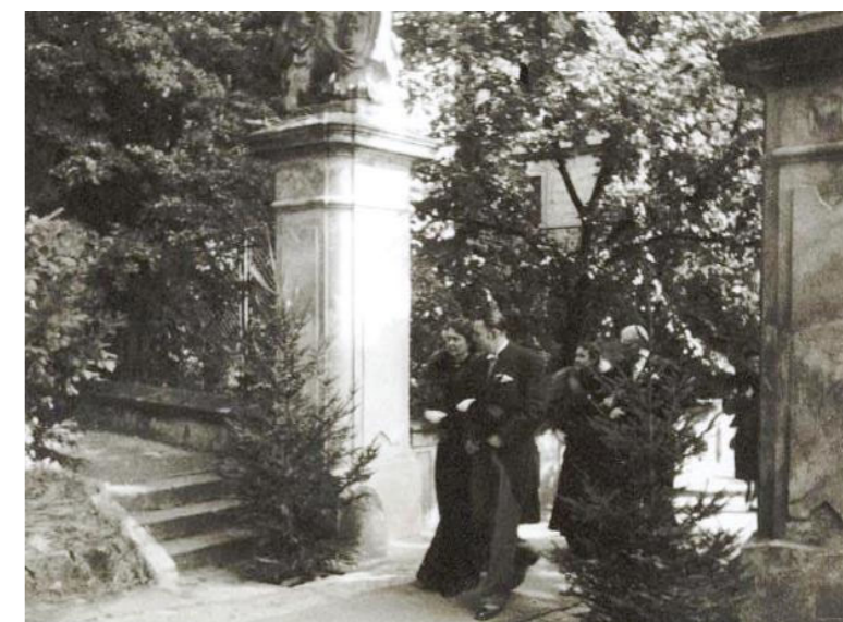
Historická fotografie zobrazující bývalé schody po stranách před mostem.
