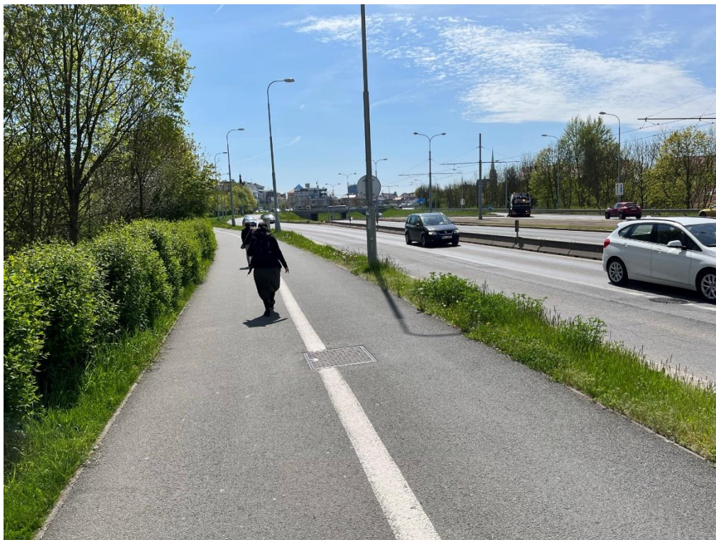
Obr. 2: Pohled na křižovatku Rondel ze severní strany z ulice Karlovarská, zdroj [2]
