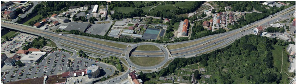
Obr.1: Pohled na stávající stav křižovatky Rondel a ulice Karlovarská, zdroj [1]
