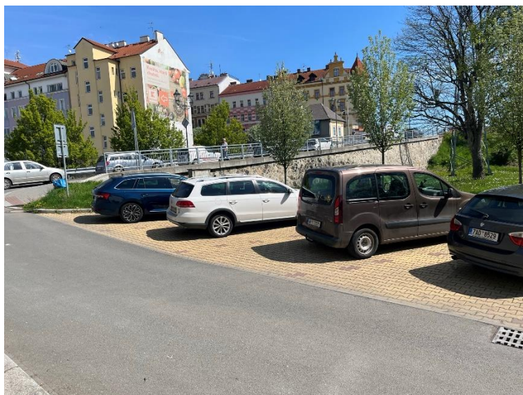
Obr. 11: Pohled na opěrnou zeď z ulice Lochotínská, zdroj [2]
