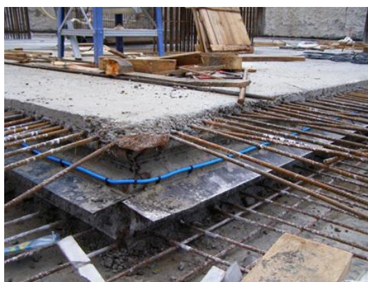
Obrázek 11 a 12 – Těsnění pracovní spáry umělohmotný pásek (vlevo) ocelový plech (vpravo) [12]
