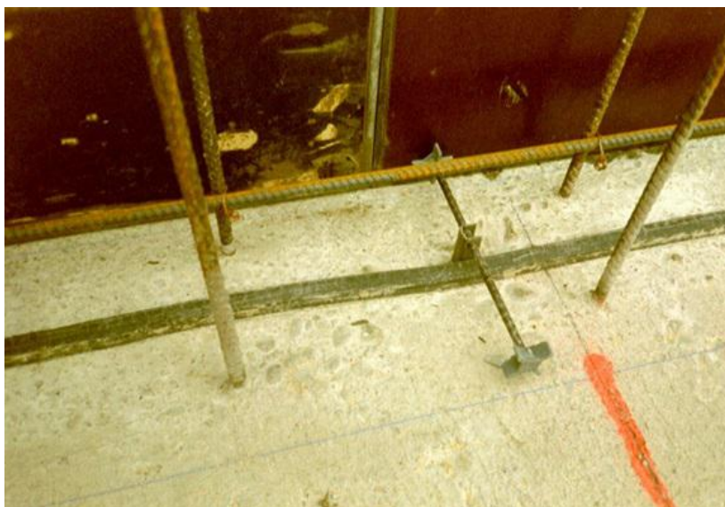
Obrázek 14 – Těsnění pracovní spáry pomocí bobtnavého pásu [12]
