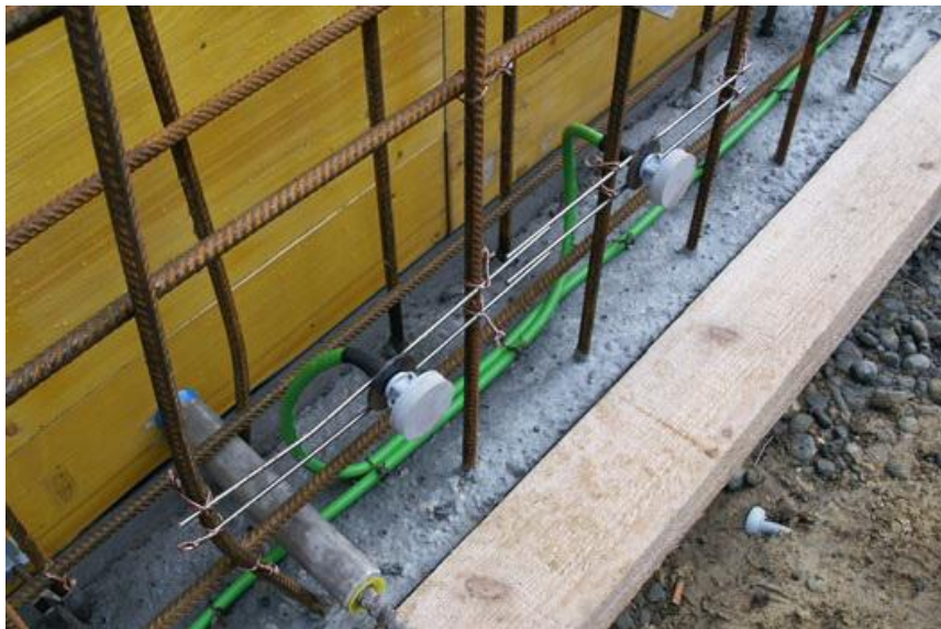
Obrázek 15 – Těsnění pracovní spáry injektážní trubičkou [12]
