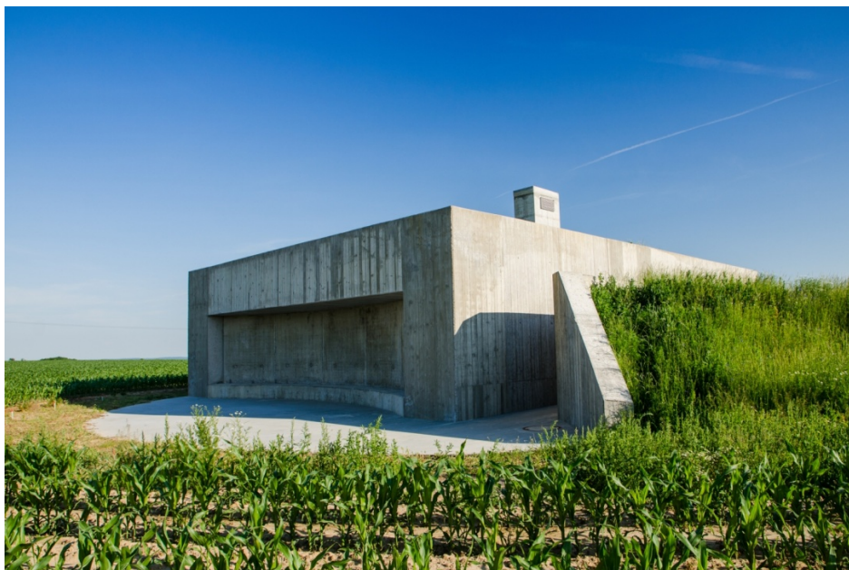
Obrázek 2 – severní pohled na vodojem [1]
