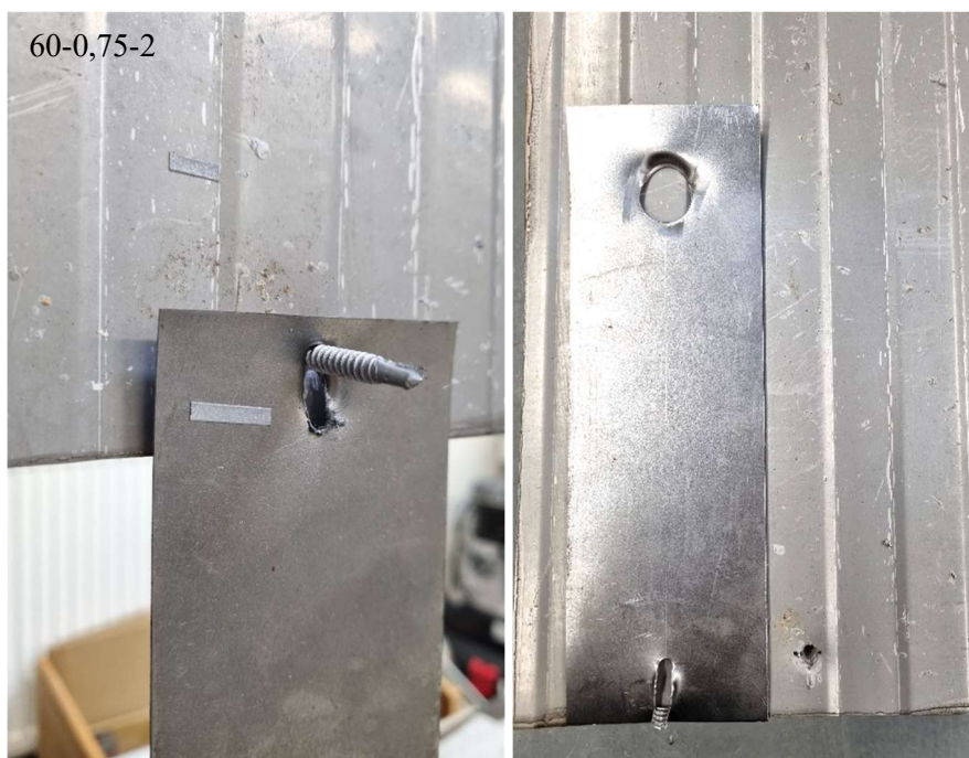
Obr. 53 Porušení přípoje – zkouška 60-0,75-2
