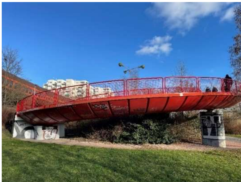
Obrázek 12 - Pohled na rampu lávky Hůrka – metro
