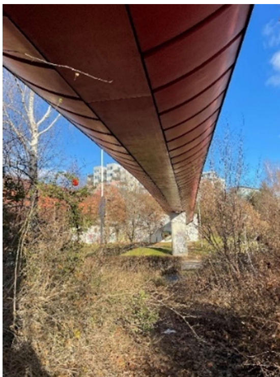
Obrázek 13 - Pohled na mostovku lávky Hůrka – metro
