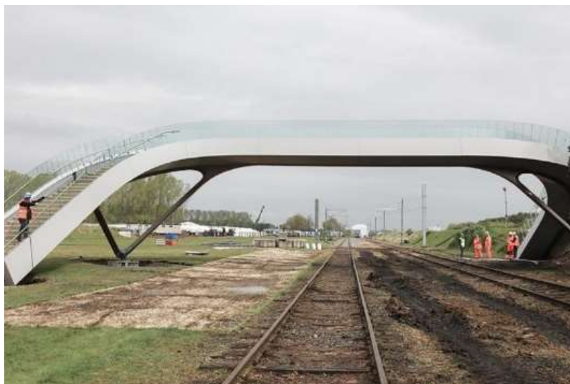
Obrázek 20 - Rail Flow Bridge
