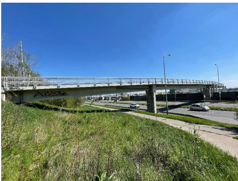
Obrázek 10 - Pohled na lávku přes ulici Jeremiášova
