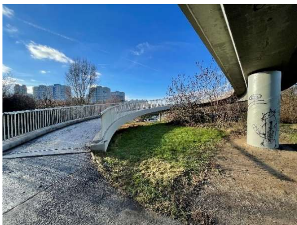
Obrázek 14 - Pohled na mostovku s rampou lávky Hůrka – autobus
