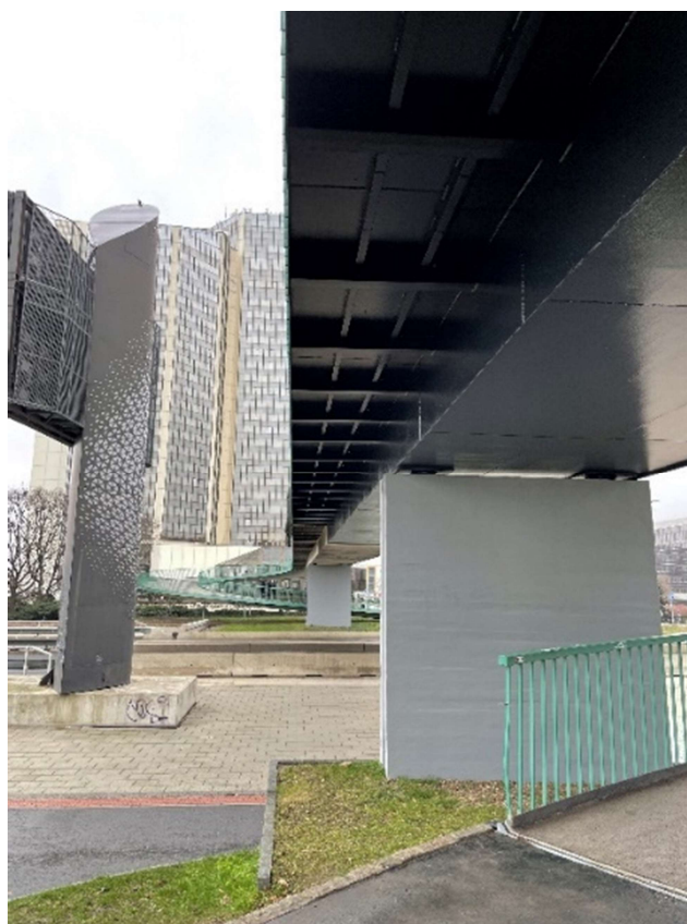
Obrázek 6 - Pohled na mostovku a stěnový pilíř lávky u Nuselského mostu
