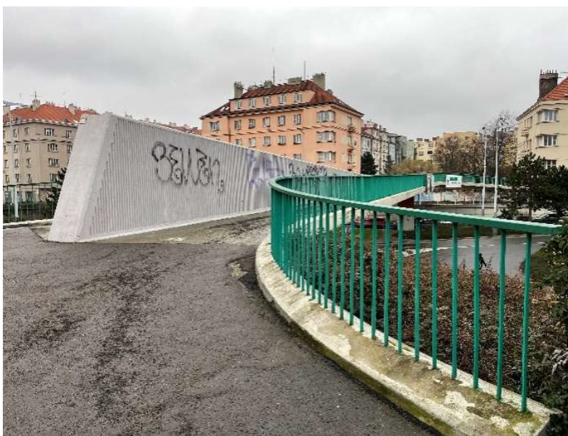
Obrázek 7 - Pohled na mostovku lávky u Kongresového centra
