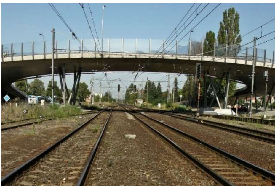
Obrázek 16 -Silniční most přes koridor v Poděbradech https://www.smp.cz/most-pres-zeleznicni-trat-ceskych-drah-podebrady-1566
