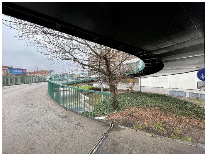
Obrázek 5 - Pohled na rampu u Nuselského mostu
