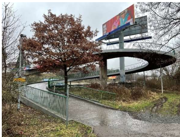
Obrázek 18 - Pohled na rampu lávka na Spořilově
