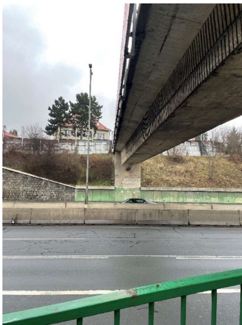
Obrázek 17 - Pohled na mostovku lávky na Spořilově
