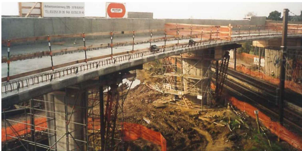
Obr. 5.14: Vysouvání se svislou výztuhou [10]
