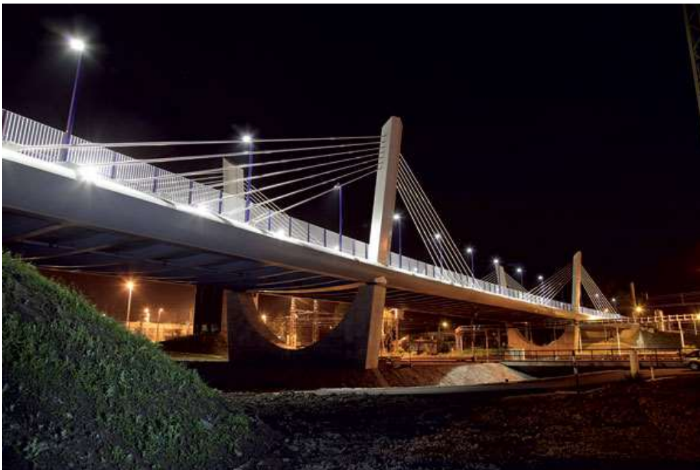
Obr. 5.33: Most v Bohumíně po dokončení [29]
