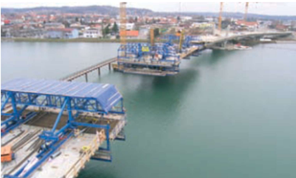
Obr. 5.23: Výstavba mostu Puch [25]
