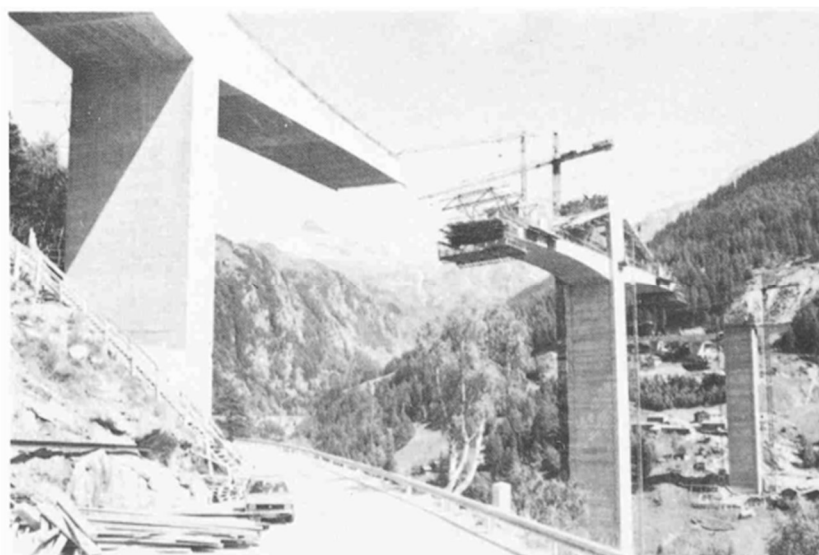
Obr. 5.18: Výstavba mostu Ganterbrücke [23]
