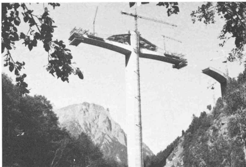
Obr. 5.17: Výstavba mostu Ganterbrücke [23]
