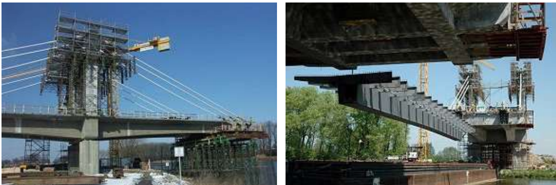
Obr. 5.37: Výstavba mostu u Nymburka [30]
