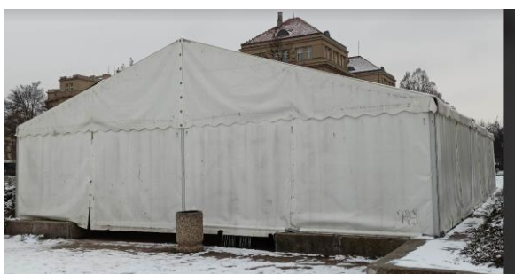
Obr. 11 Stan s ocelovou konstrukcí [autor]
