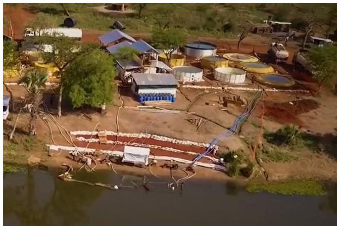
Obr. 5 MSF sedimentační filtrace produkce 2 000 [m3/den] pitné vody [L12]
