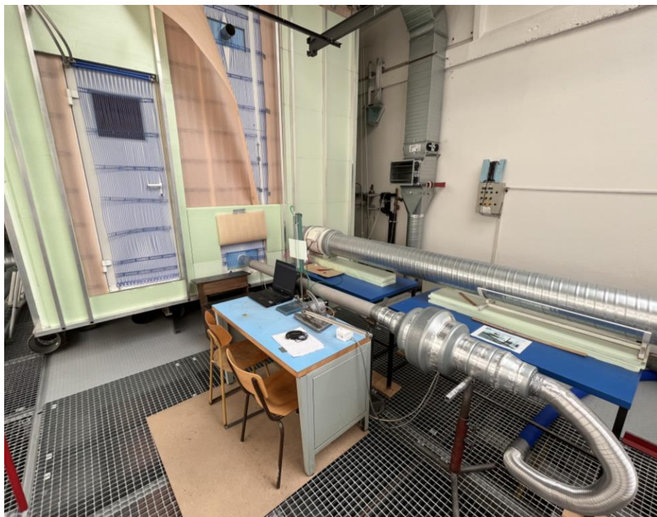
Obr. 48: Pohled na clonkovou trať s ventilátorem a měřicí komoru zvenku
