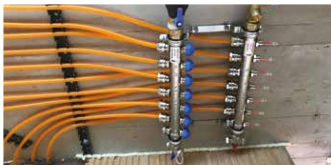
4. Montáž rozdělovače
