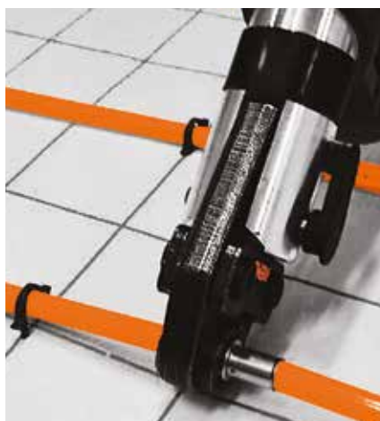
3. Spojení trubek lisovaným spojem
