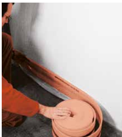
1. Položení dilatačních pásů
