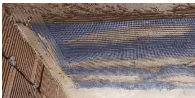
6. Instalace sklotextilní výztuže
