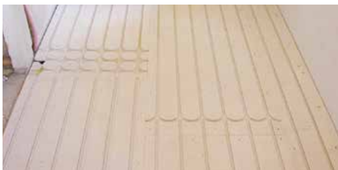
2. Nalepení a přivrutování systémových desek Gabotherm® KB 12 18 mm
