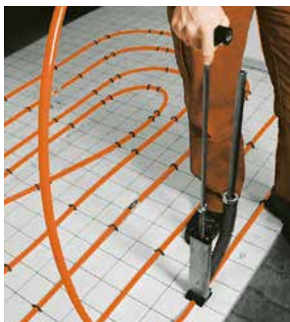
2. ukládání trubky do spirály (po položení systémových pásů)
