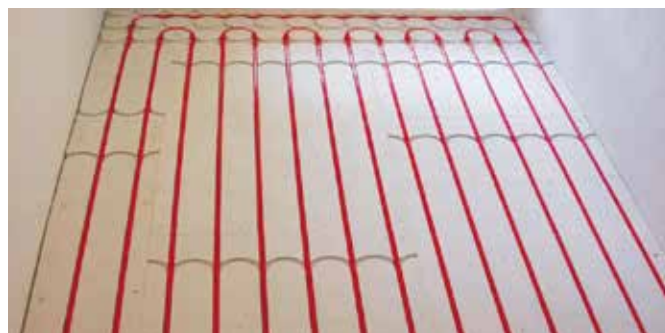
3. Pokládka trubky Gabotherm® hetta PB-R 12x1,3 mm
