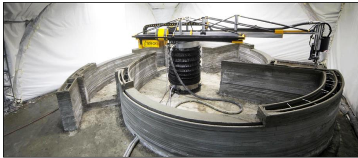
Obr. 10: 3D tisk betonu (polární konstrukce) [1]
